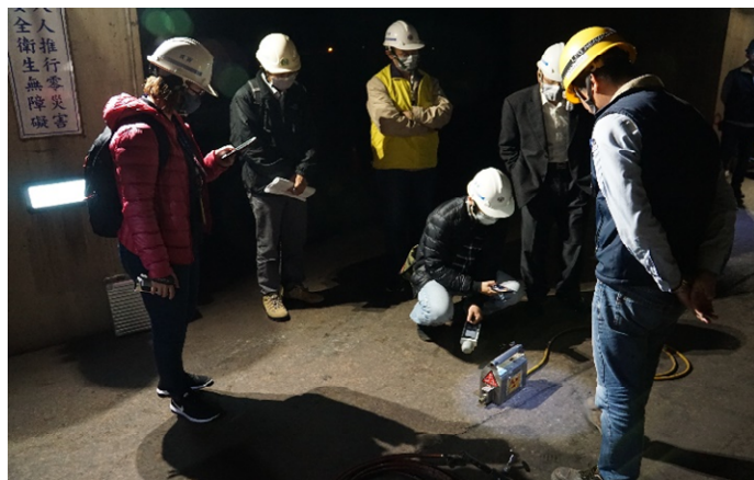
放射線照相檢驗業工地輻安稽查
