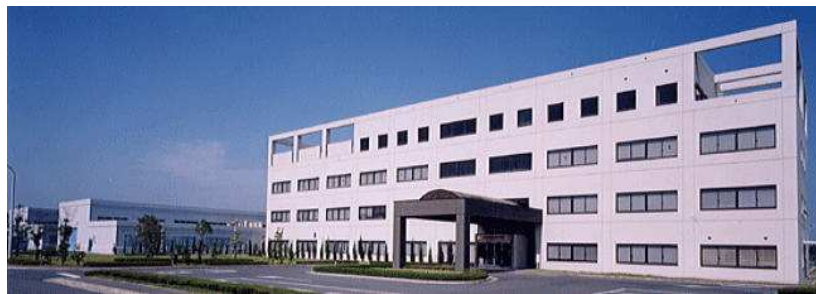
圖 7. JAEA 所屬之 ENTRY 設施
