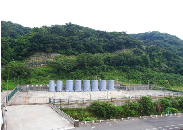
圖 6 核一廠乾式貯存場現址
