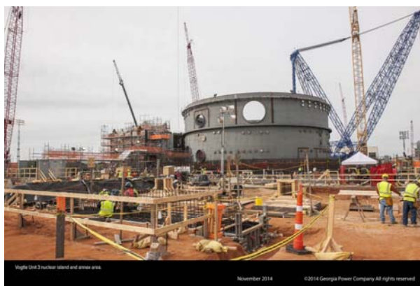
圖 5： Vogtle 3 號機反應器廠房及附屬設施之建設現況 (資料來源：喬治亞電力公司)
