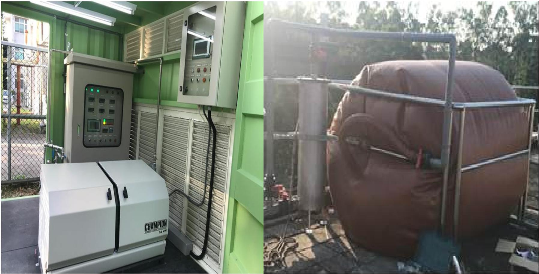
圖 24 生質沼氣聯網示範系統之發電機組及沼氣貯存設備
