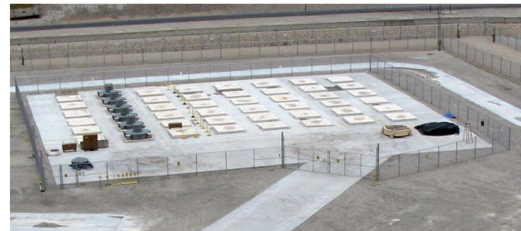
圖 5:Callaway 電廠用過核燃料乾式貯存場
