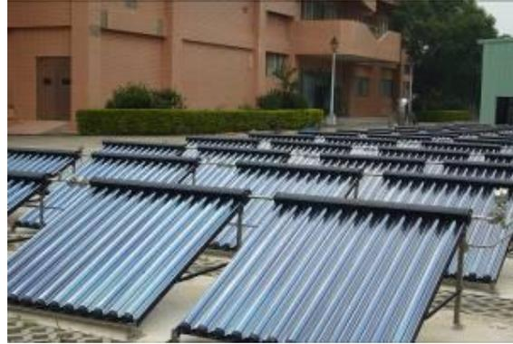
總集熱面積約 86m<sup>2</sup> 之太陽能 U 型真空管集熱器
