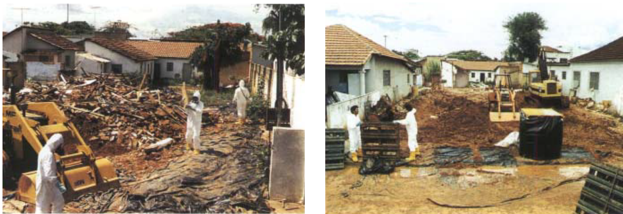
圖 32 R.A.住宅拆除作業殘骸
