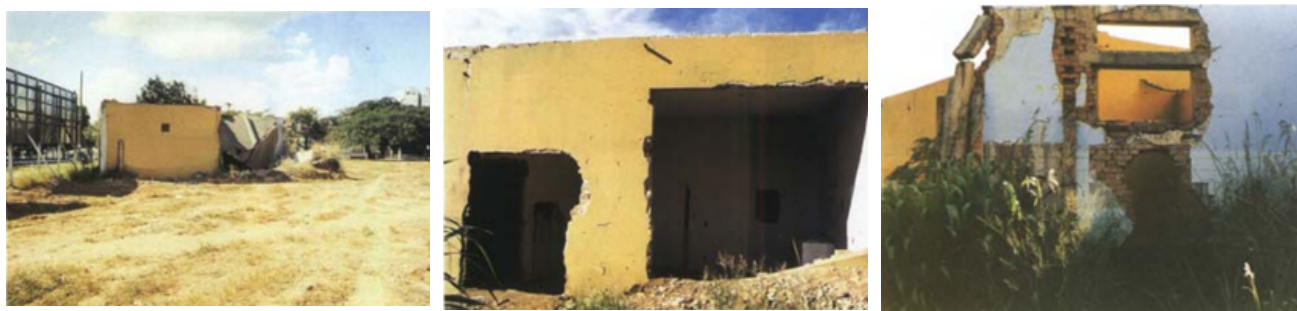
圖 5 部分建物遭拆除之廢棄 IGR 中心
