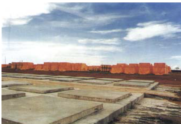
圖 33 設有混凝土基座及逕流取樣溝槽的臨時貯存場
