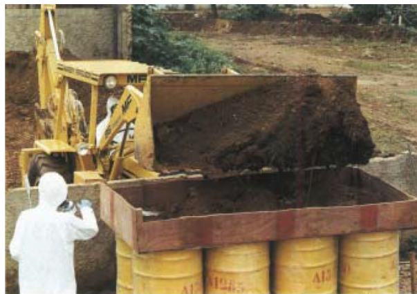
圖 36 受污染土壤填裝至 8 個桶槽
