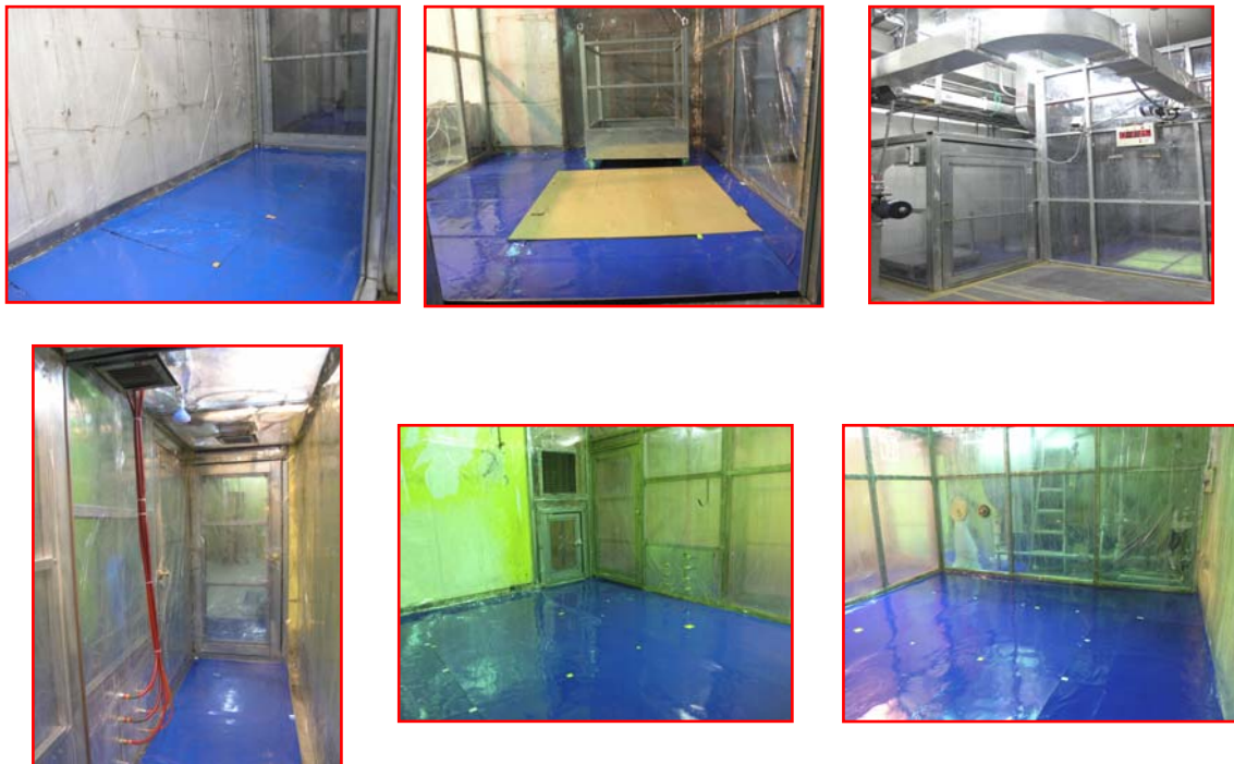
圖 1-3-6、016 館分析線鉛室除污(拆除)隔離操作區建置
