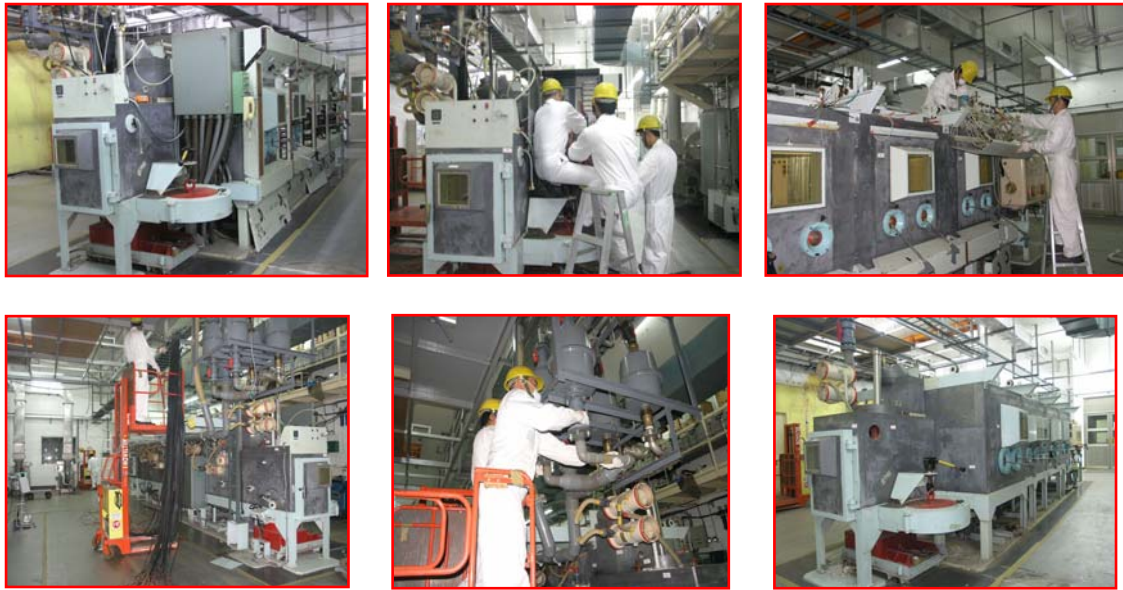
圖 1-3-7、016 館分析線鉛室周邊設施拆除
