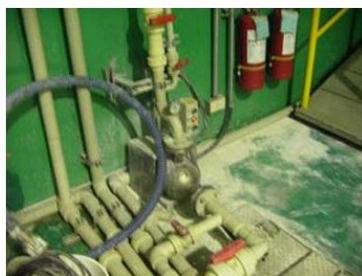
圖 2-2-3、廢水離心輸送泵更換為隔膜泵避免氣縛現象
