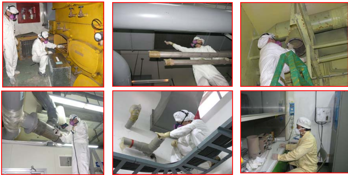
圖1-3-5、016館超鈾污染設施取樣偵檢
