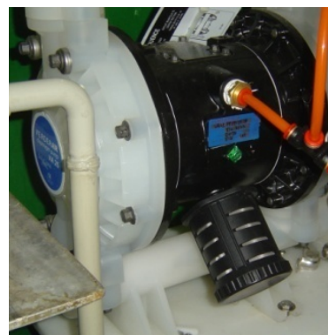
圖 2-2-2、液鹼泵維修更換成隔膜泵
