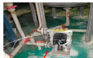
圖 2-2-4、廢水輸送泵 P-201 易卡物更換為隔膜泵
