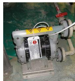
圖 2-2-4、廢水輸送泵 P-201 易卡物更換為隔膜泵
