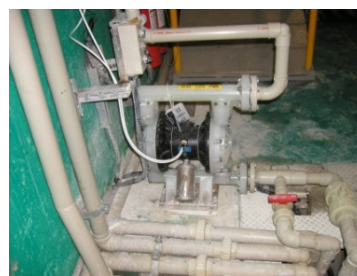
圖 2-2-3、廢水離心輸送泵更換為隔膜泵避免氣縛現象
