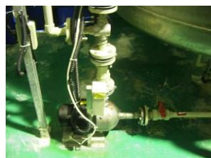
圖 2-2-3、廢水離心輸送泵更換為隔膜泵避免氣縛現象
