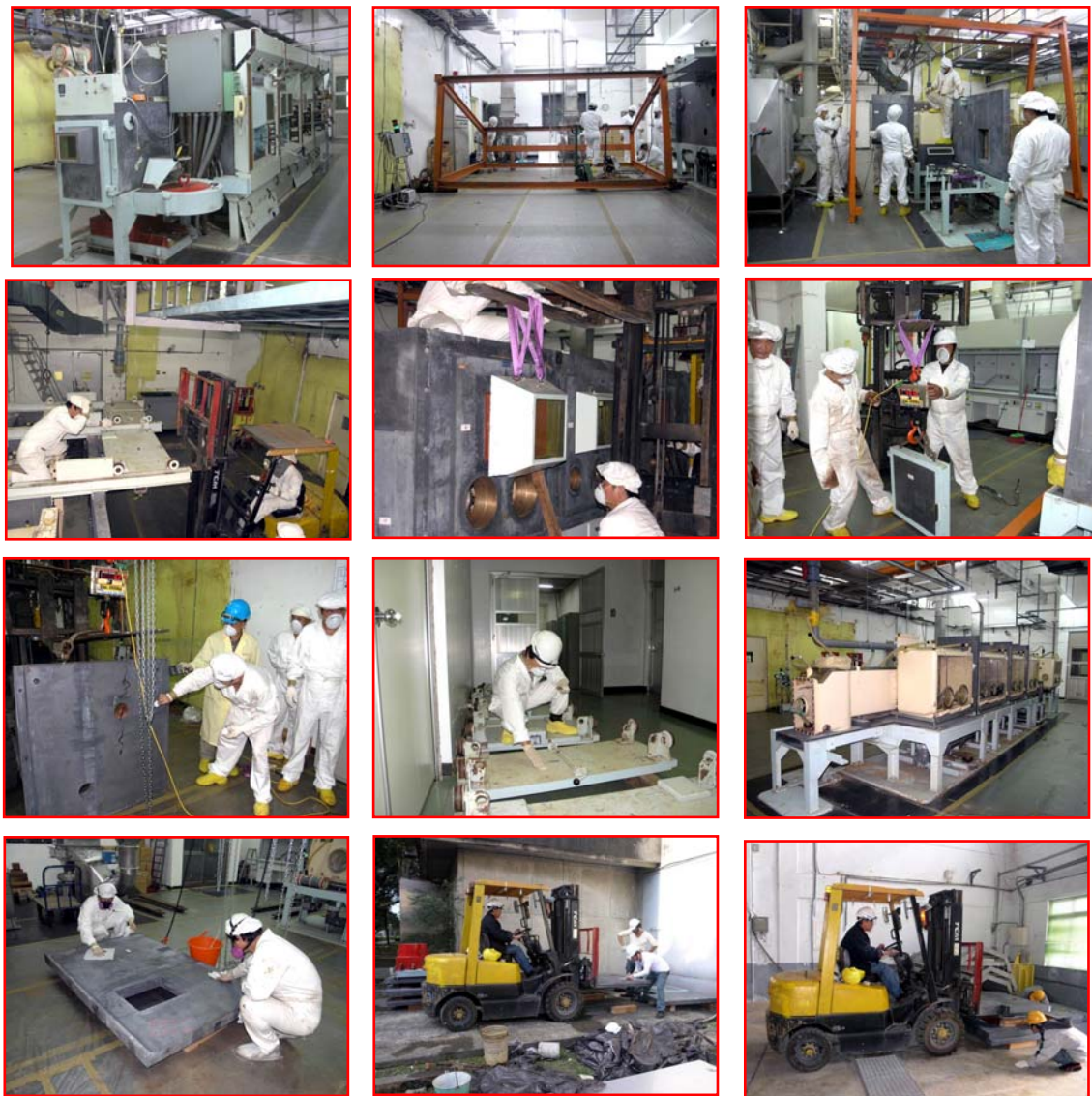
圖 1-3-9、016 館分析線鉛室鉛屏拆除、除污與運貯
