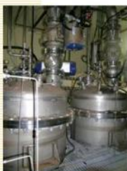
新式進料系統完工照片
