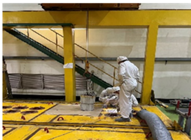
圖 2-5：高活度廢棄物地下貯存庫(015D)10-12 號窖(圓型井)清理
