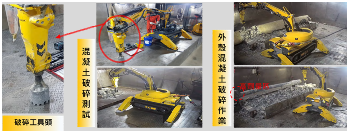
圖 2-3：高劑量貯存孔外殼混凝土破碎作業
