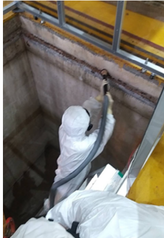
圖 2-6：高活度廢棄物地下貯存庫(015D)2 號窖除污作業
