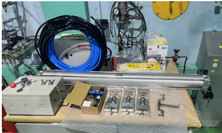
圖 2-7：熱室內測試燃料貯存罐傳動系統
