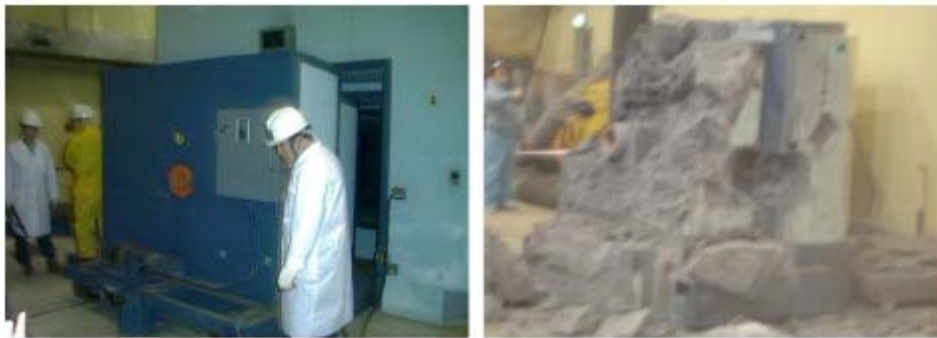
圖 1.3.29 現場拆卸熱柱門[13]
