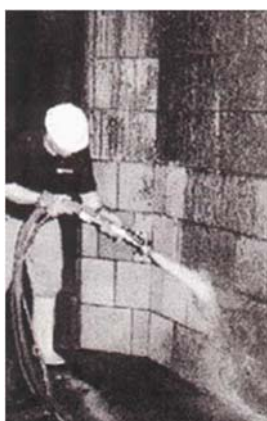
圖 1.1. 14 軟性介質噴砂技術示意圖
