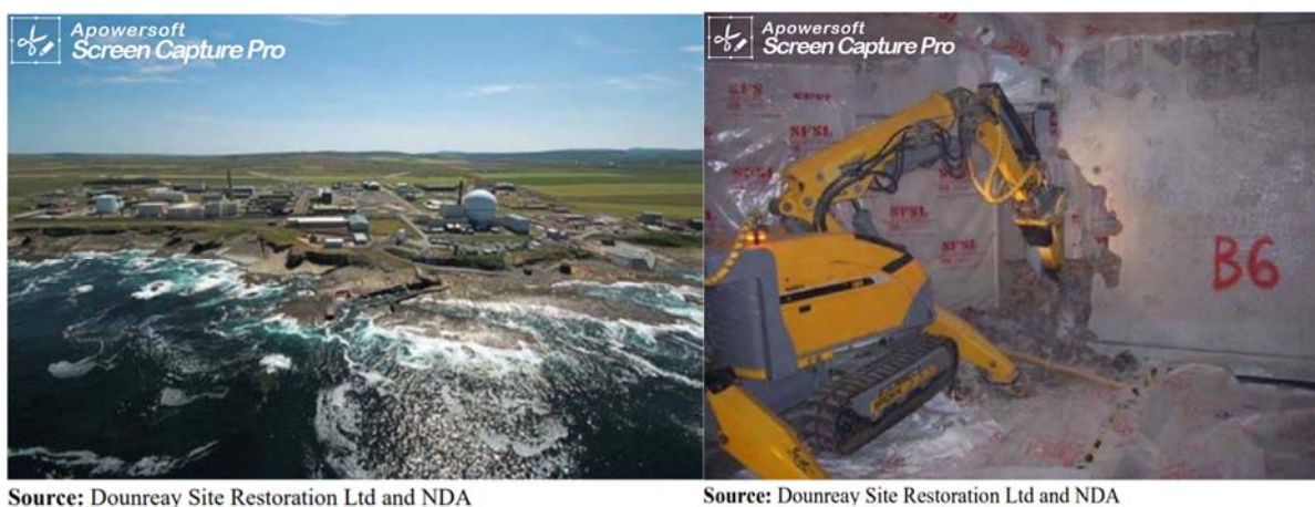
圖 1.2. 7 Dounreay 反應爐與拆除用的 Brokk 機器人
