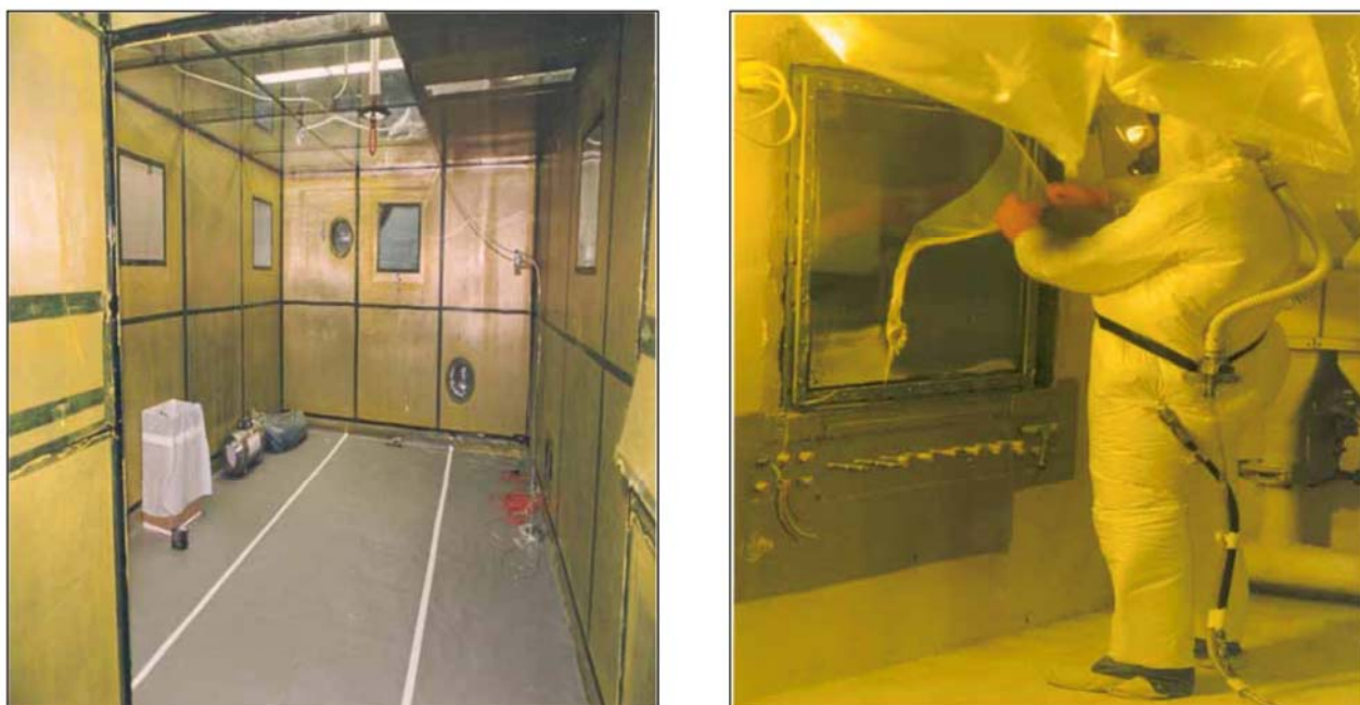
圖 1.2.1 實際除污情形與施作人員保護措施
