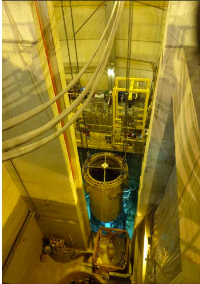
圖 1.3.6 西班牙何塞·卡布雷拉(José Cabrera)拆除反應器爐穴與用過燃料池之間的牆體[3]
