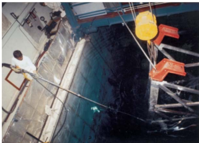
圖 1.2.12 加拿大 Gentilly-1 的鋼結構在水中經由 hydrolaser lance 除污
