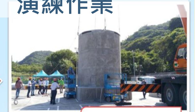
外加屏蔽吊裝作業
