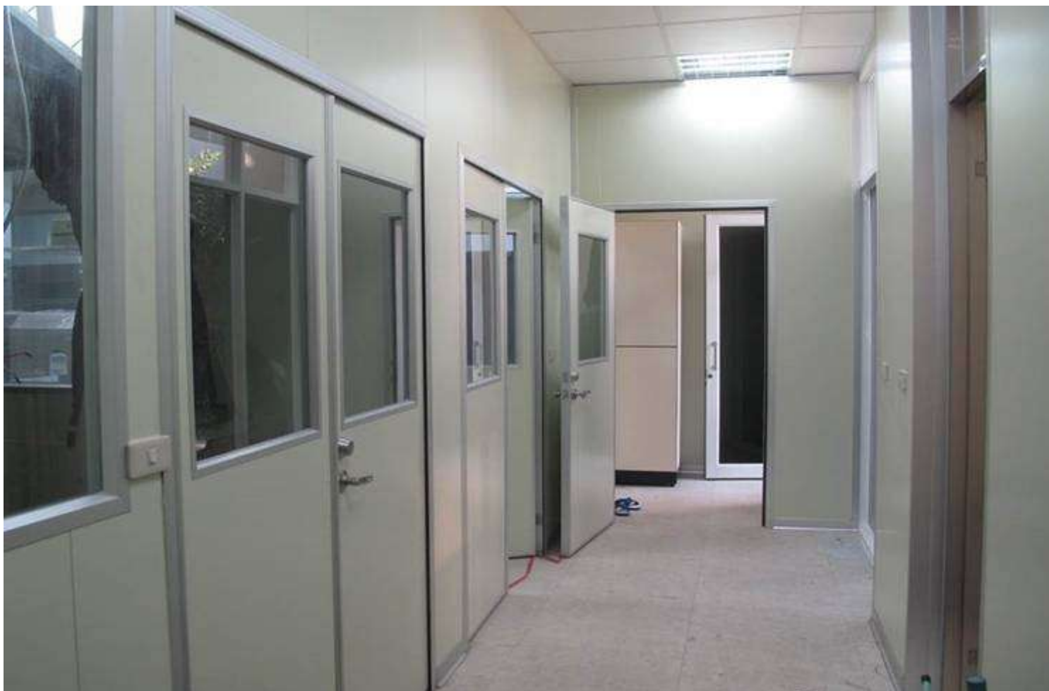
圖 47. 質譜儀實驗室外圍緩衝區庫板隔間實景
