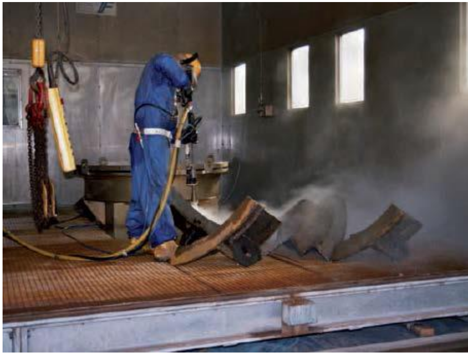
高壓水噴射之除污作業方式
