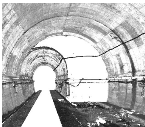
圖3.2-2 隧道雷射掃描3D點雲 (邱顯晉及林金成，2015)
