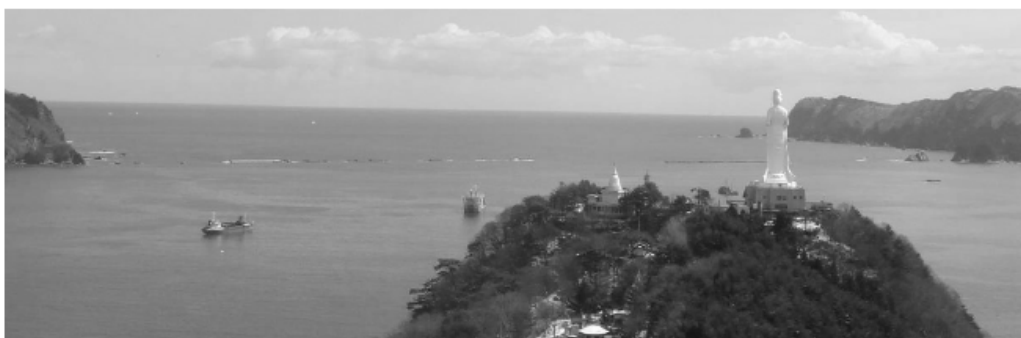
圖 14 釜石灣口防波堤損壞情形（全景）[2]
