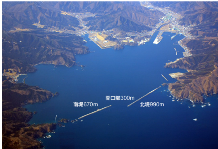
圖 5 日本釜石灣口防波堤[2]
