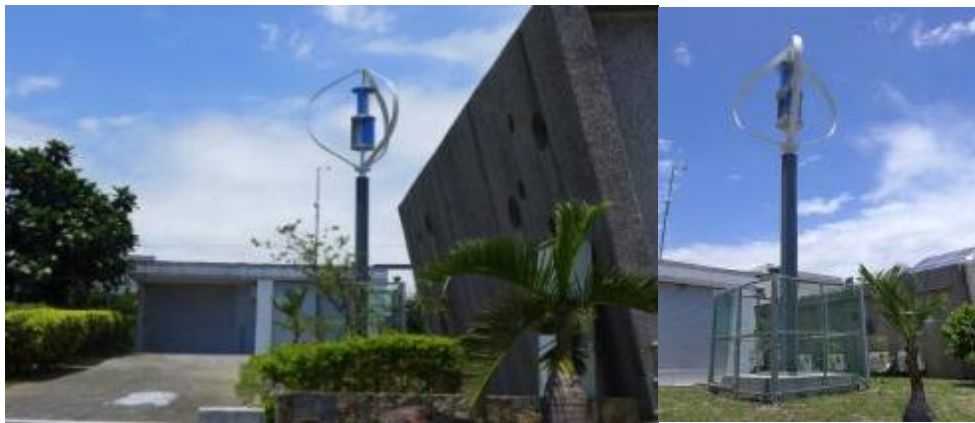
圖 24、標準檢驗局花蓮分局 3KW 小型垂直軸風力機安裝實照
