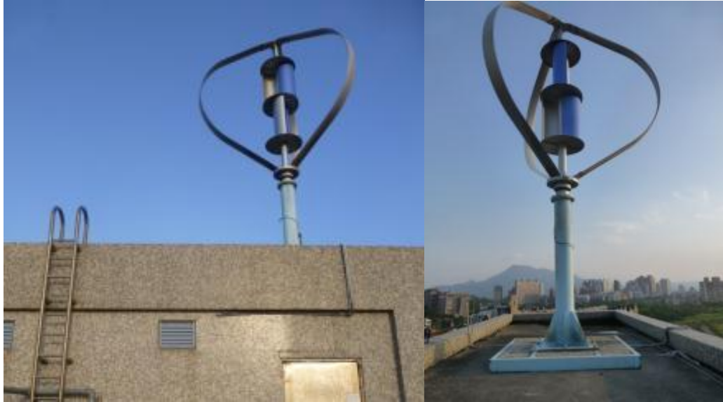
圖 20、淡水海洋技術學院 3KW 小型垂直軸風力機安裝實照
