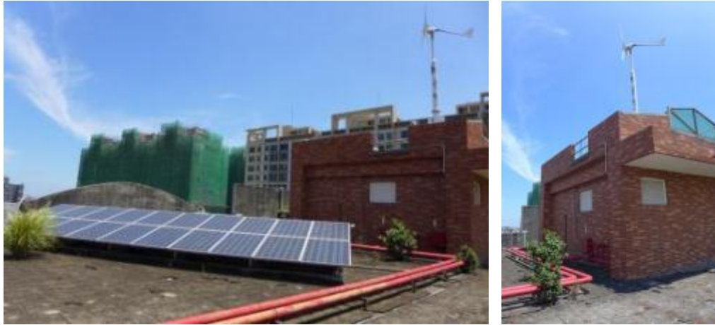
圖 19、新竹高工 2KW 小型水平軸風力機安裝實照
