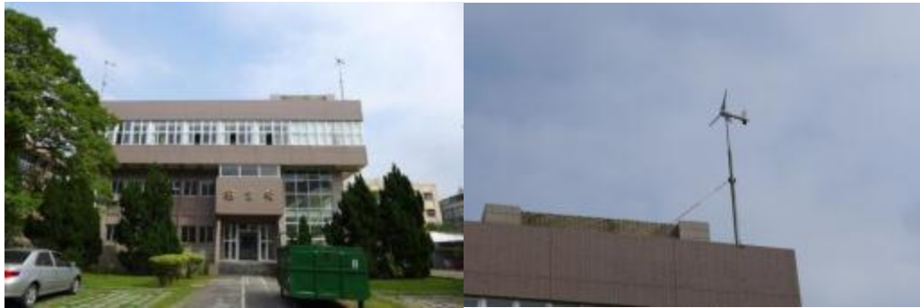
圖 18、龍潭農工 600W 小型水平軸風力機安裝實照
