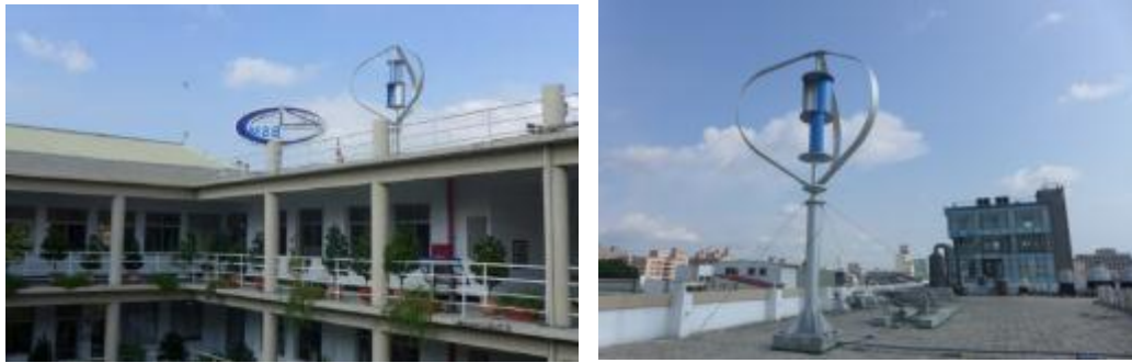
圖 22、標準檢驗局台南分局 3KW 小型垂直軸風力機安裝實照
