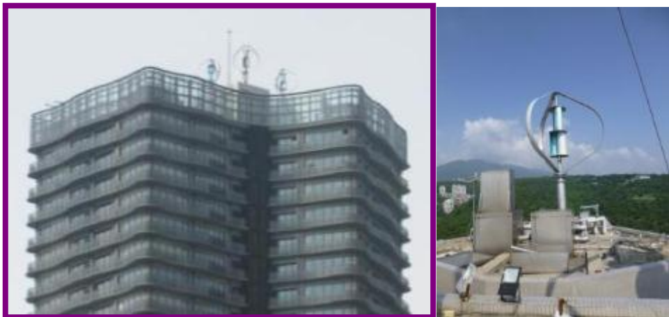
圖 27、淡水海納川藍海社區 3KW 小型垂直軸風力機安裝實照
