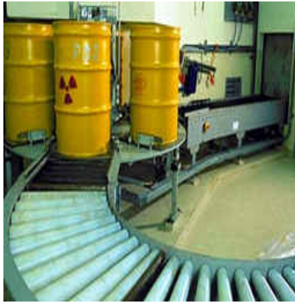
圖 2-4(a) 廢棄物桶固化運送至貯存庫[91]
