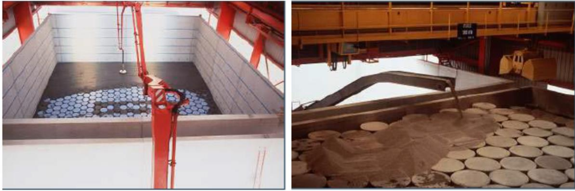
圖 29 用混凝土回填 CSFMA LLW 處置窖（左圖），用礫石回填 ILW 處置窖（右圖）(NOS, 2014)
