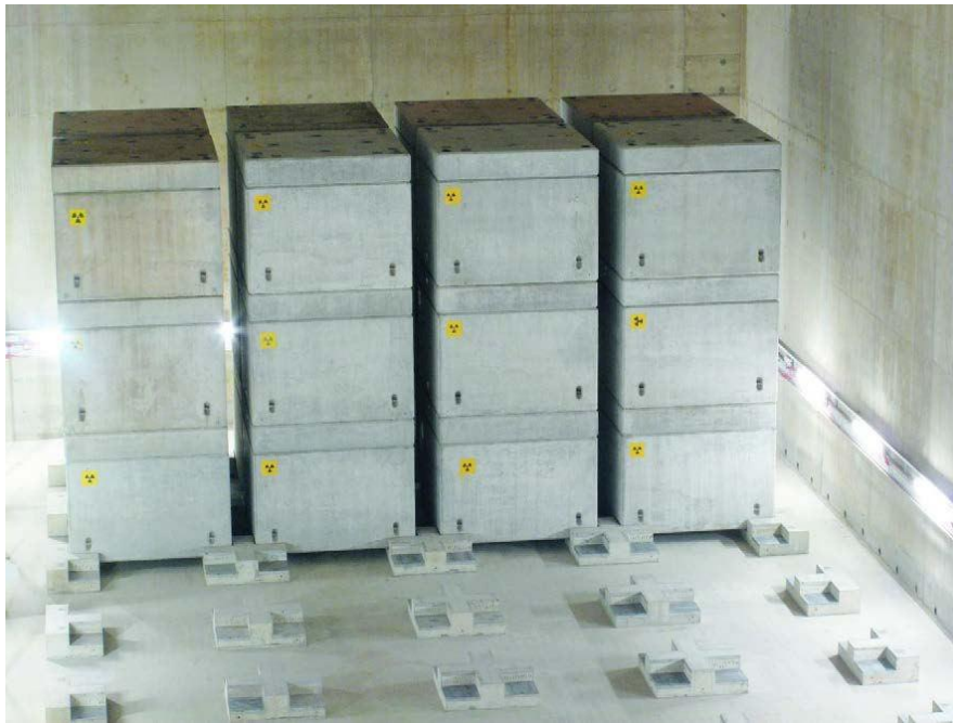
圖 49 英國 Trawsfynydd 核電廠的 ILW 貯存設施 (IAEA, 2018)
