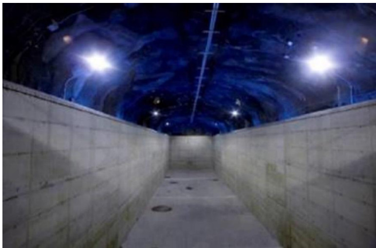
圖 35 芬蘭 Loviisa 處置場之 ILW 處置坑道(Garamszeghy, 2021)
