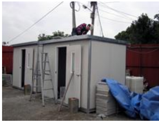
圖 17 建築節能效益全尺寸實驗施工
