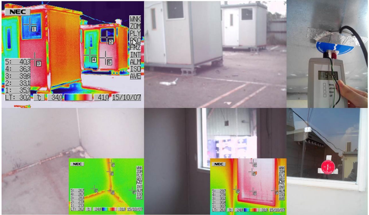
圖 18 實驗屋之隔熱性能檢查
