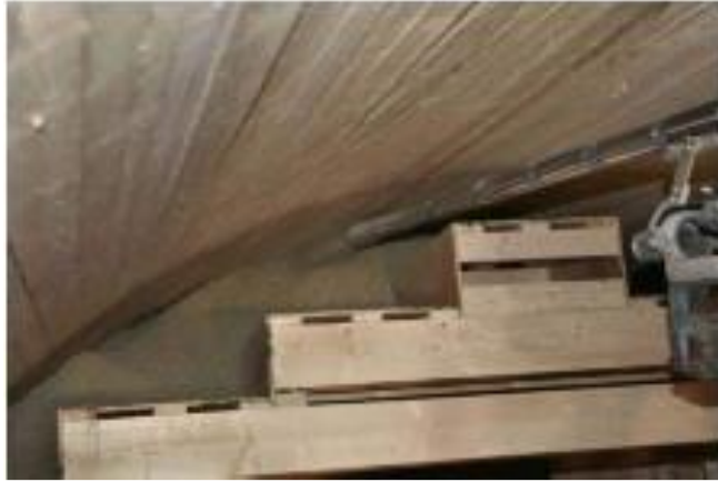
圖 4.20 回填顆粒置放(TR-10-16)
