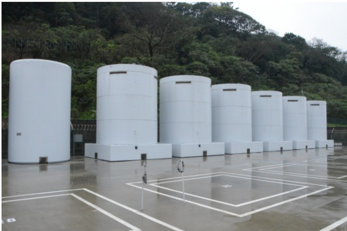
圖 1、核一廠乾貯護箱實體與未來安裝位置之地面標記
