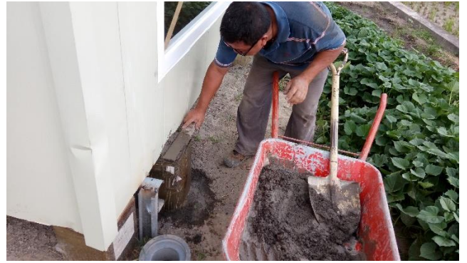
圖 50.實驗屋底座加裝水泥桶加強載重
