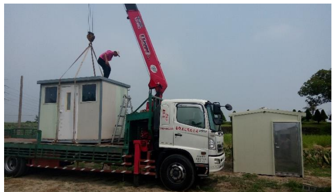
圖 31.實驗屋現場吊掛(二)
