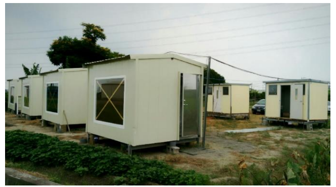
圖 35.實驗屋施工完成(一)
