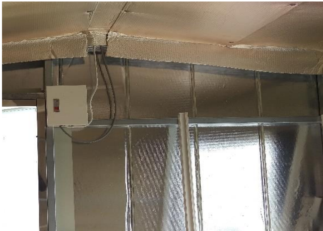
圖 32.實驗屋室內牆體安裝隔熱毯(一)
