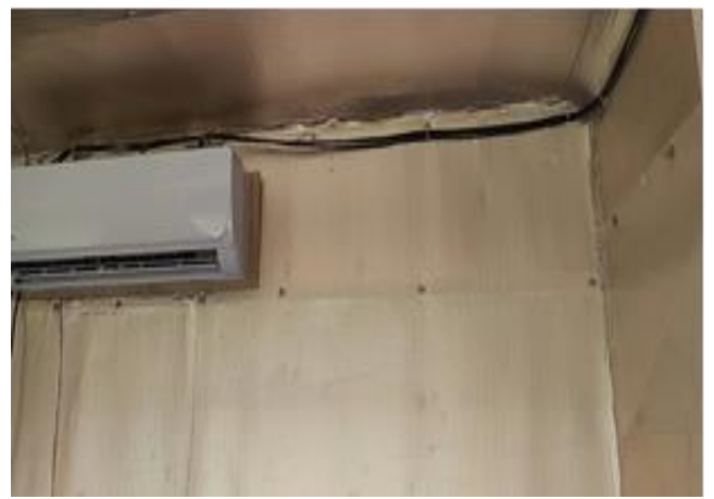
圖 33.實驗屋室內牆體安裝隔熱毯(二)
