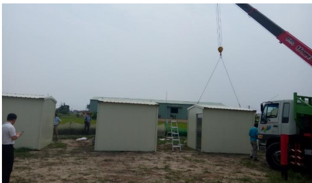
圖 30.實驗屋現場吊掛(一)
