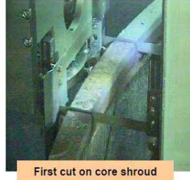
圖 十二、Stade 核電廠除役進行不可移動內部組件拆解
