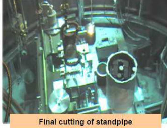
圖 十二、Stade 核電廠除役進行不可移動內部組件拆解
