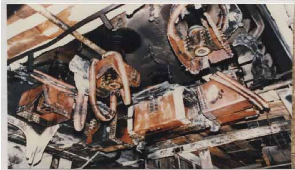
圖2-8 相隔離母線匯流排燒毀情形
