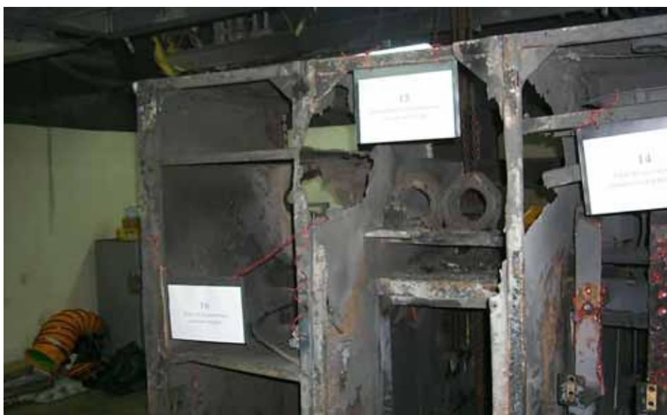
圖 2-10 匯流排之盤面損壞情形
