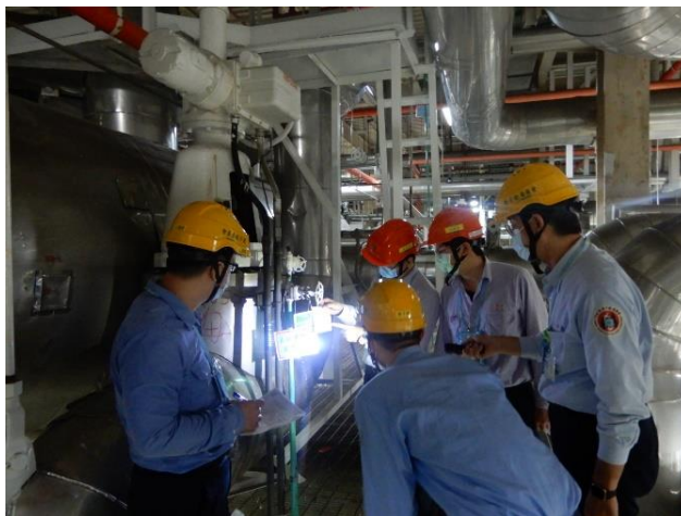
圖 7 原能會視察員 111 年 12 月 12 日執行核一廠汽機廠房飼水加熱器設備拆除區域現場視察
