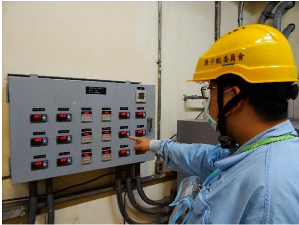
圖29 執行核三廠現場設備視察
