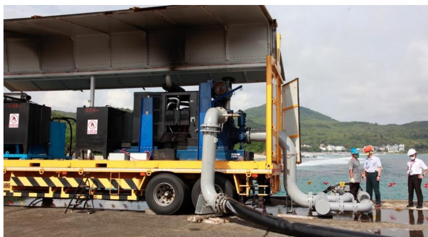
圖40 111年核能三廠演習-移動式第二熱沉佈線引接及抽海水演練
