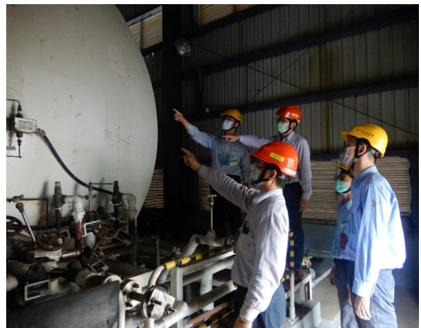
圖 8 原能會視察員 111 年 12 月 12 日執行核一廠氮氣槽設備拆除區域現場視察
