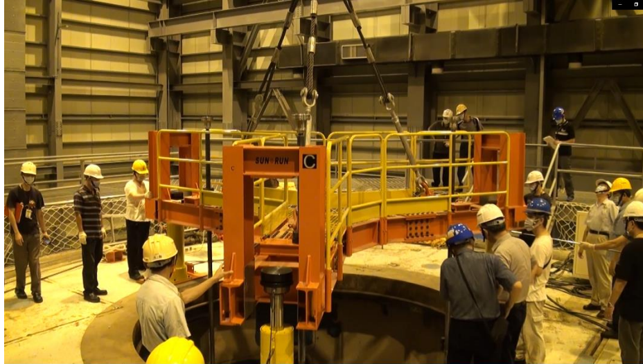
圖 26 Y 型鬆動機具測試作業
