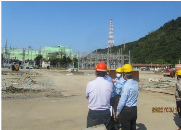
圖 5 原能會視察員 111 年 3 月 11 日查證核一廠氣渦輪機廠房拆除完成作業
