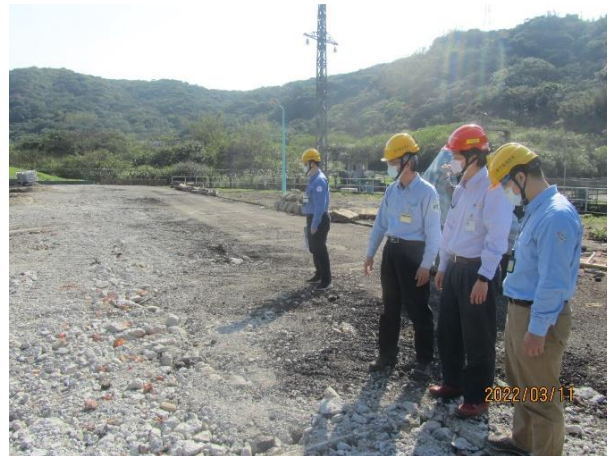
圖 6 原能會視察員 111 年 3 月 11 日查證核一廠氣渦輪機油槽拆除完成作業
