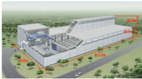
圖 9、各國鋼筋混凝土結構之室內乾貯廠房(a)德國 STEAG[23]、(b)德國 WTII[23]、(c)日本 RFS[8]、(d)荷蘭 HABOG[32]
