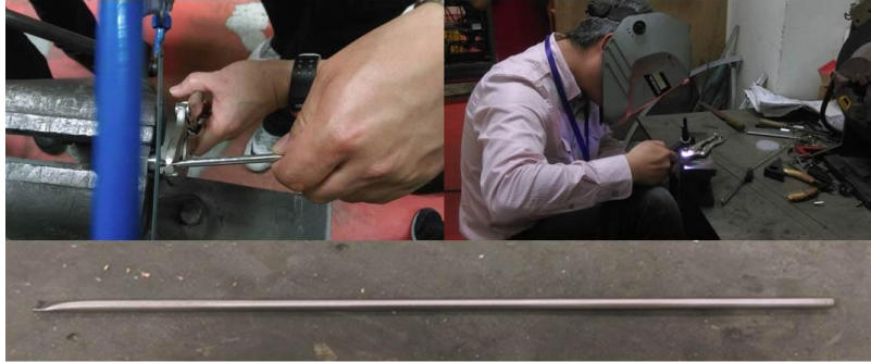
切管焊接封口完成
