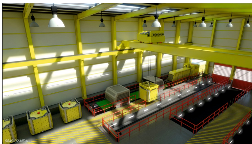
圖 3-9 低發熱廢棄物之地面轉運設施
