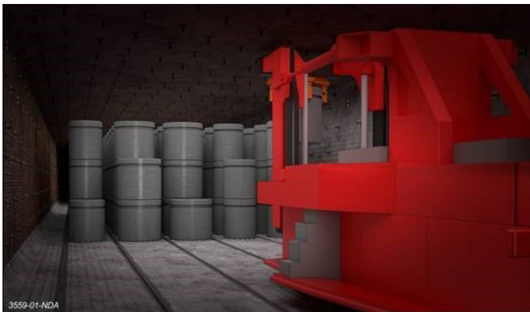
圖 3-31 堆放在蒸發岩中的專用處置窖內的 1 立方公尺混凝土桶和 500 公升桶
