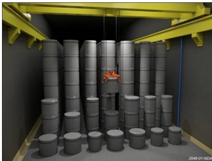
圖 3-29 堆放在高強度岩石專用處置窖內的 1 立方公尺混凝土桶和 500 公升混凝土桶
