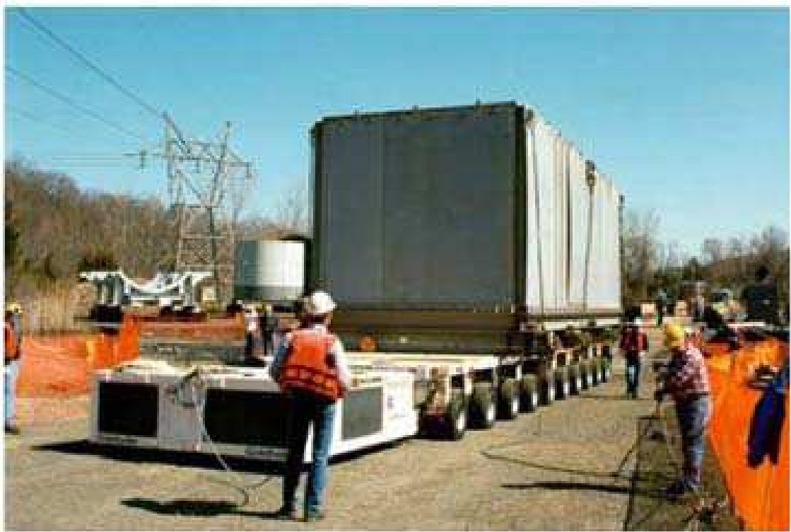
圖 3.13 安裝蒸汽產生器下部組件置拖車上
