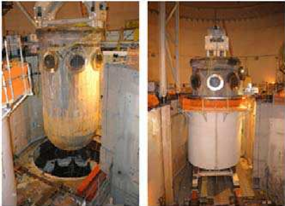
圖 3.7 反應器壓力槽的移除
