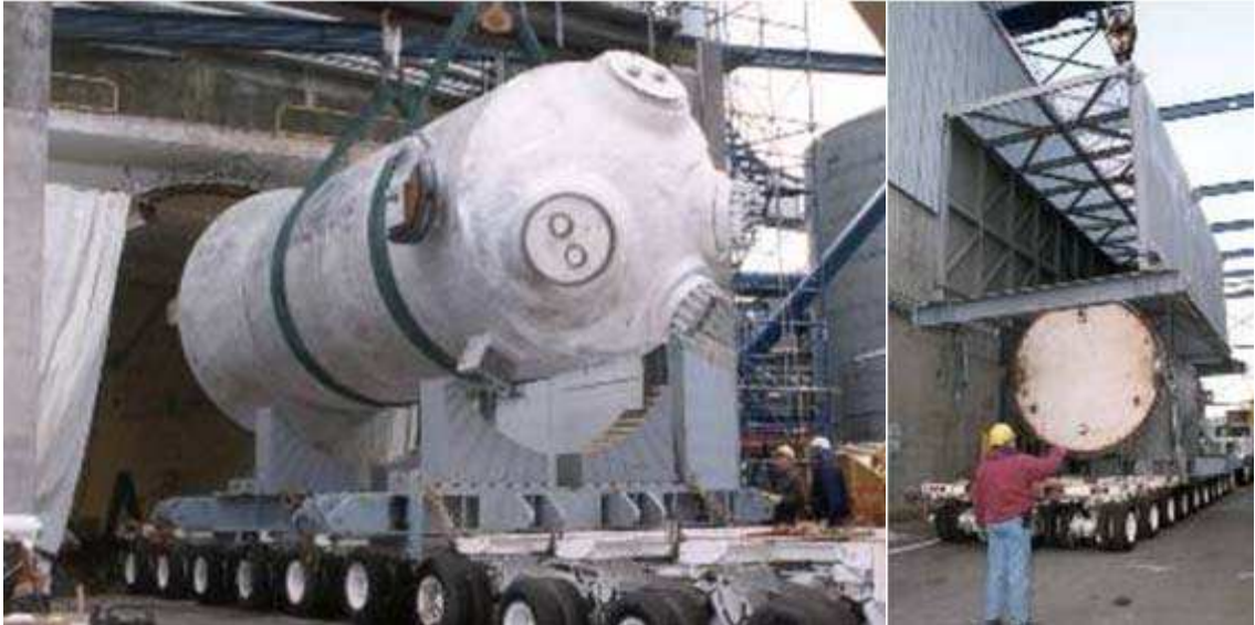
圖 3.12 移動蒸汽產生器下部組件出廠房
