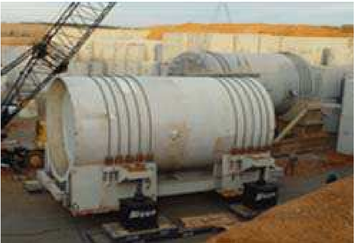
圖 3.10 反應器壓力槽最終運至 Barnwell
