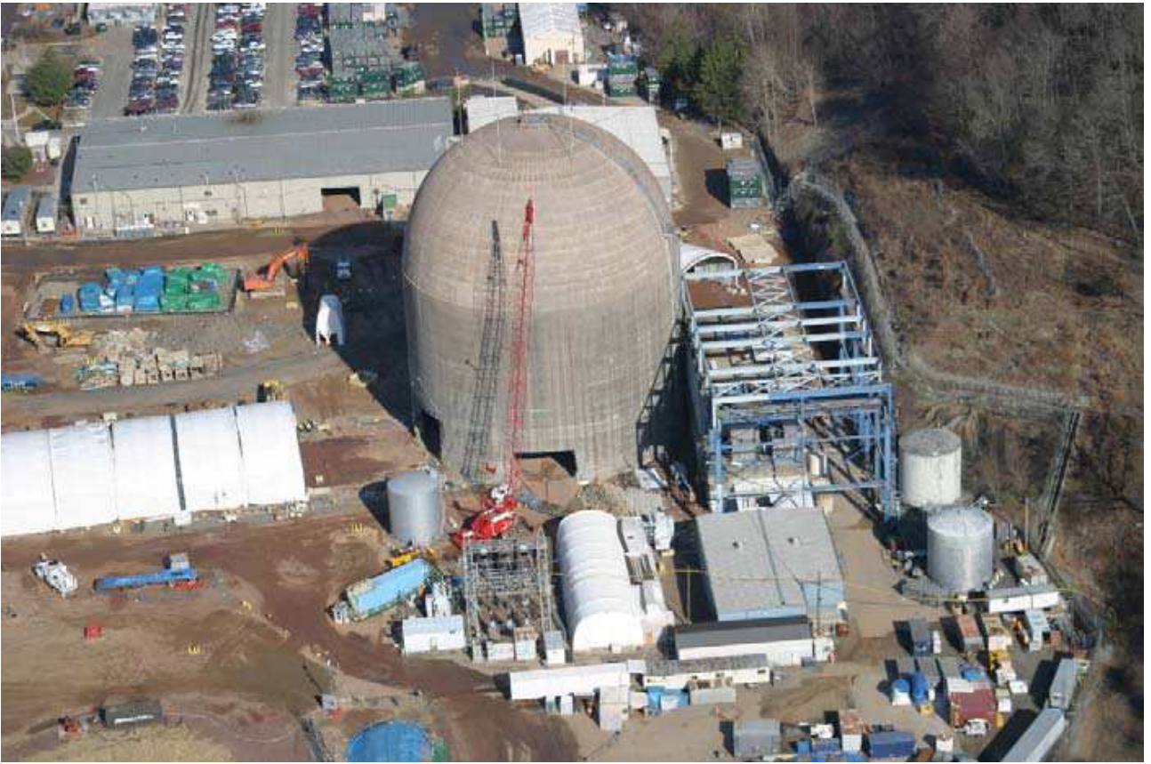
圖 3.3 開始拆除圍阻體 2006 年電廠的外觀照片
