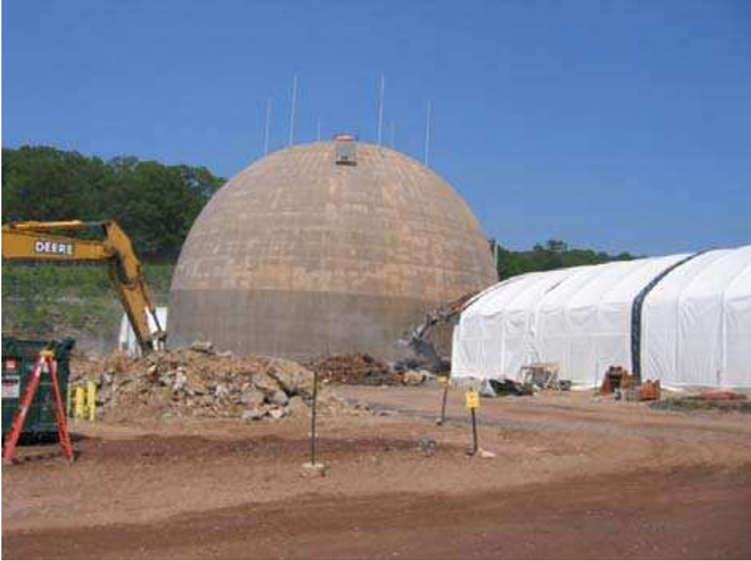
圖 3.20 圍阻體結構下降 10 英尺的距離
