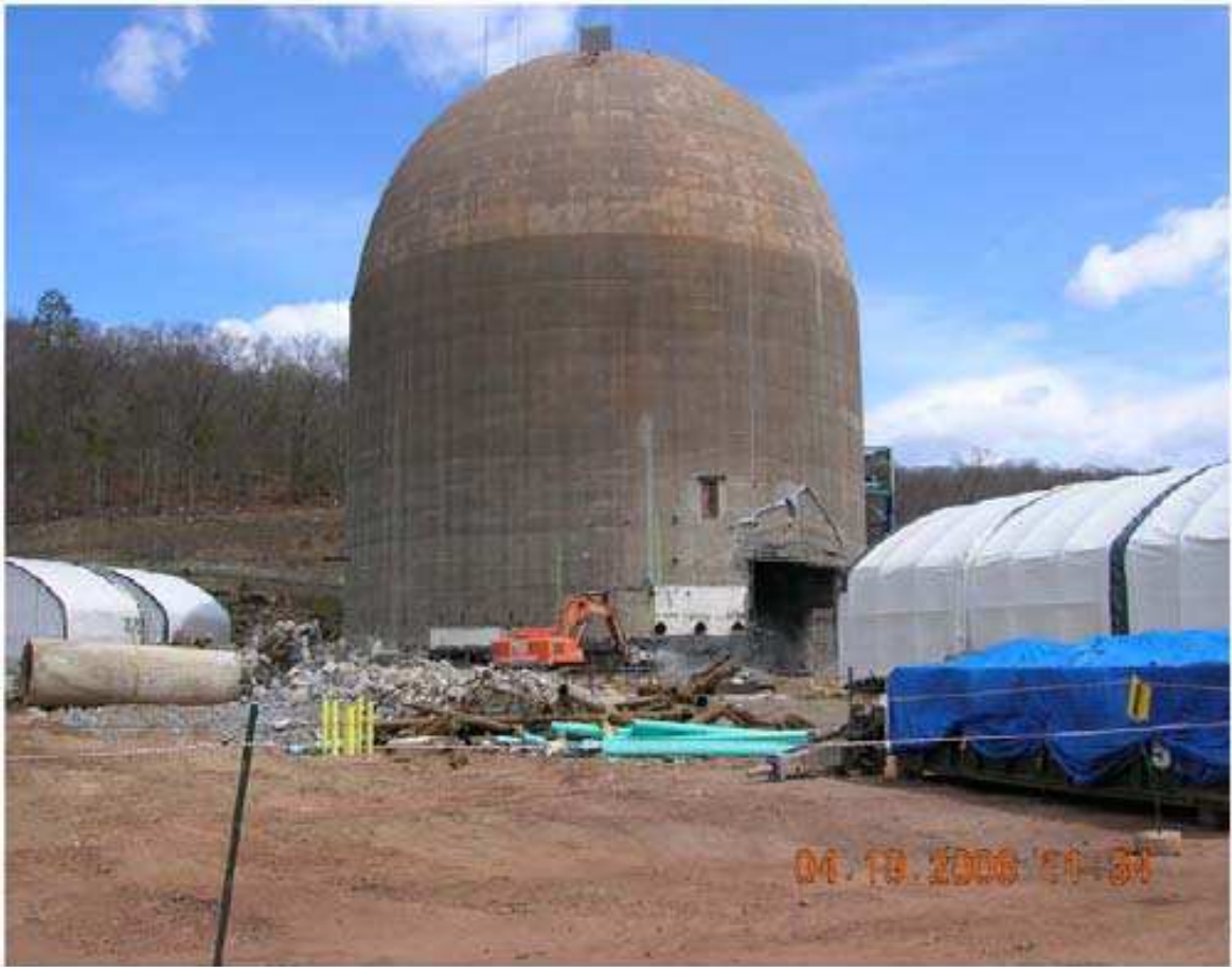
圖 3.18 使用挖掘機耙除混凝土
