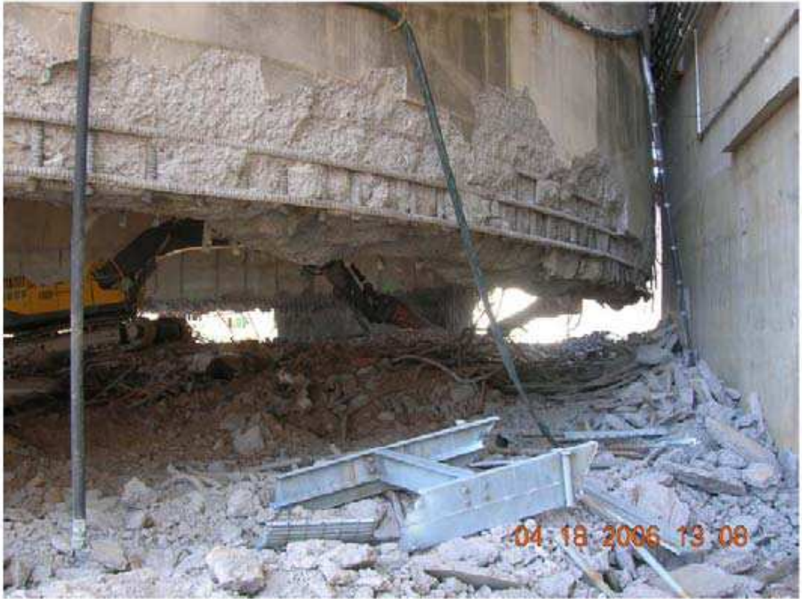
圖 3.17 液壓撞擊鉗移除腳支柱
