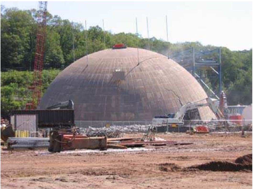
圖 3.21 圍阻體圓頂被拆除
