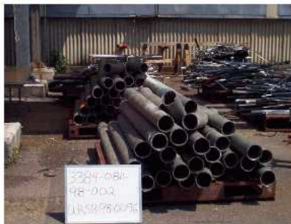
圖十二 已切割可外釋偵檢之大管路
