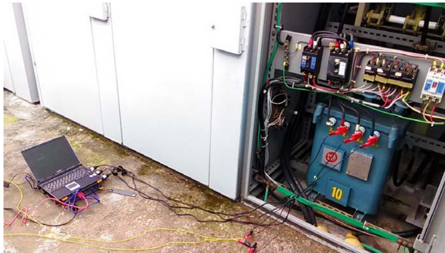
圖 3.25 雙電源相序現場測試圖(一)
