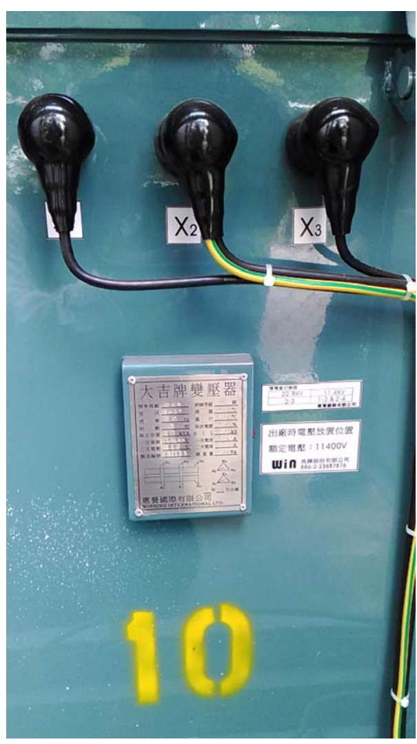
圖 2.14 QQ38 電源 PT 二次側正視圖與銘牌
