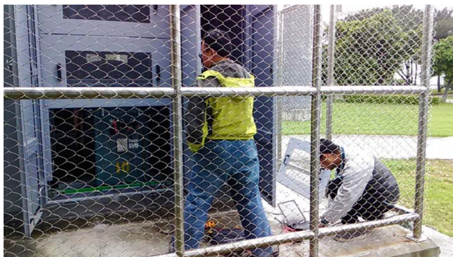
圖 3.26 雙電源相序現場測試圖(二)
