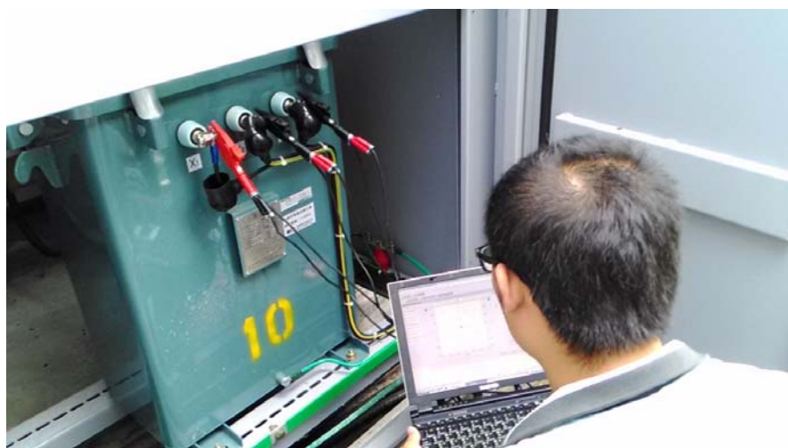
圖 3.28 電源相序現場測試圖(四)
