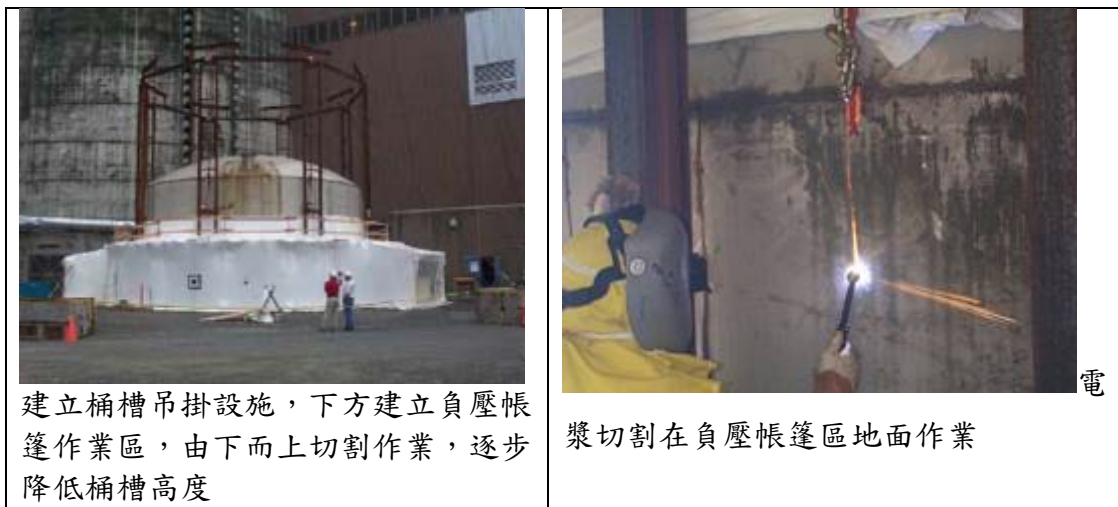
圖 6-3 燃料裝填水儲存槽拆除作業
