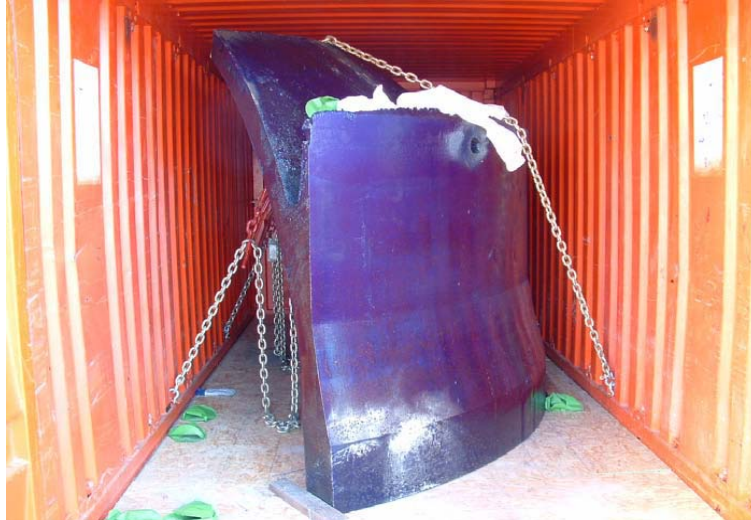
圖 5-6 RPV 爐體其他部位切割件廢棄物包裝與運輸
