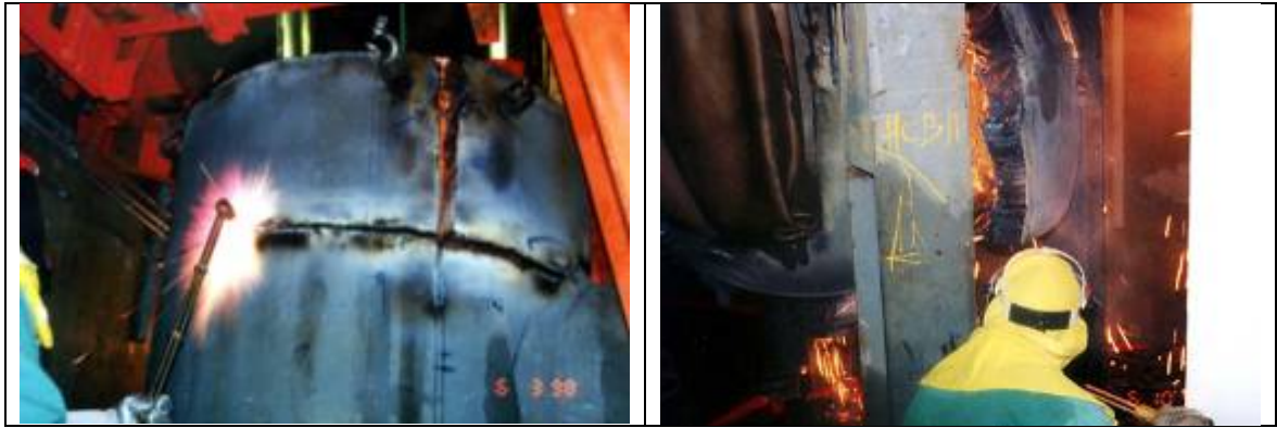
圖 6-1 由上往下切割，採用火炬切割
