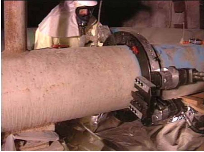
圖 3-20 軌道切割機用於輻射區切斷鋼管
