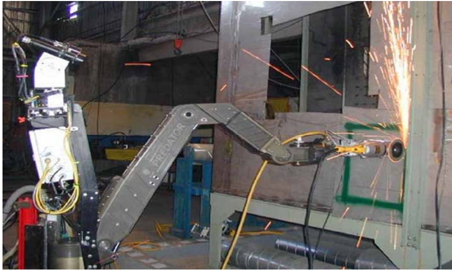
圖 3-27 機械手攜帶圓盤鋸切割鋼板
