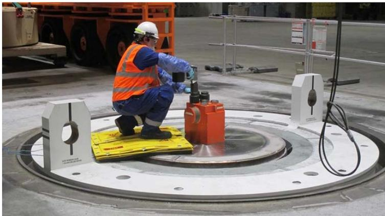
圖 3.11、廠方人員蹲在鉛屏蔽上移除鋼筒的耳軸塊(trunnion block)[32]
