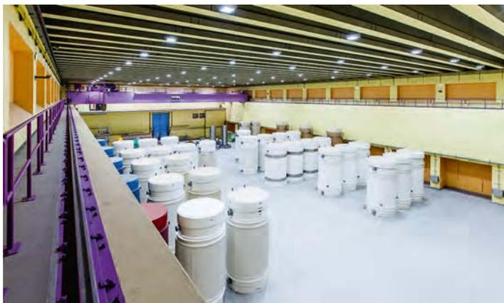
圖 3.2、ZZL 設施高階放射性廢棄物以及用過核子燃料貯存廳
