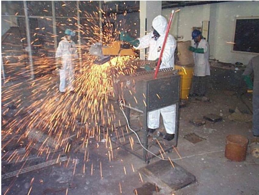
圖 36：砂輪機現場切割鋼材(IPEN/CNEN-SP)
