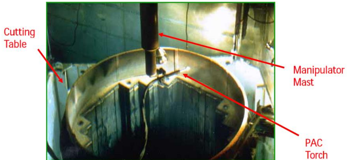
圖 9：電漿火炬切割爐心筒(Yankee Rowe)
