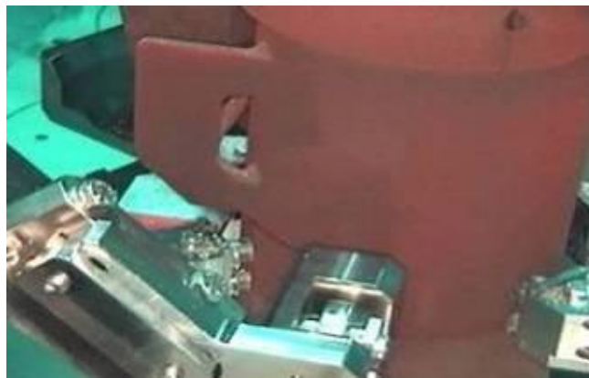
圖 21：帶鋸切割噴射泵(Würgassen)
