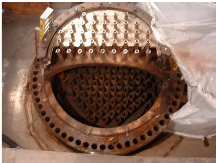
圖 33：鑽石索具切割反應器頂蓋(Rancho Seco)
