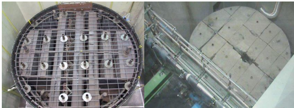
圖 32：蒸氣乾燥器灌注水泥後用鑽石索具切割(Würgassen)
