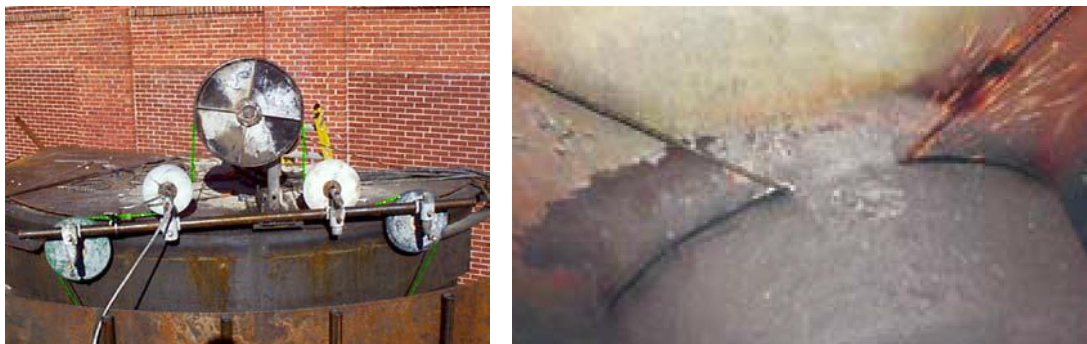
圖 30：鑽石索具架設及切割過程
