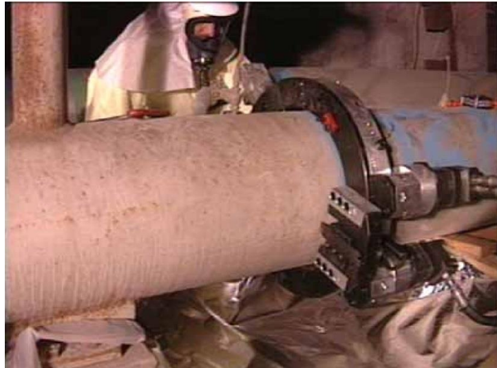
圖 37：自動軌道切割機用於輻射區
