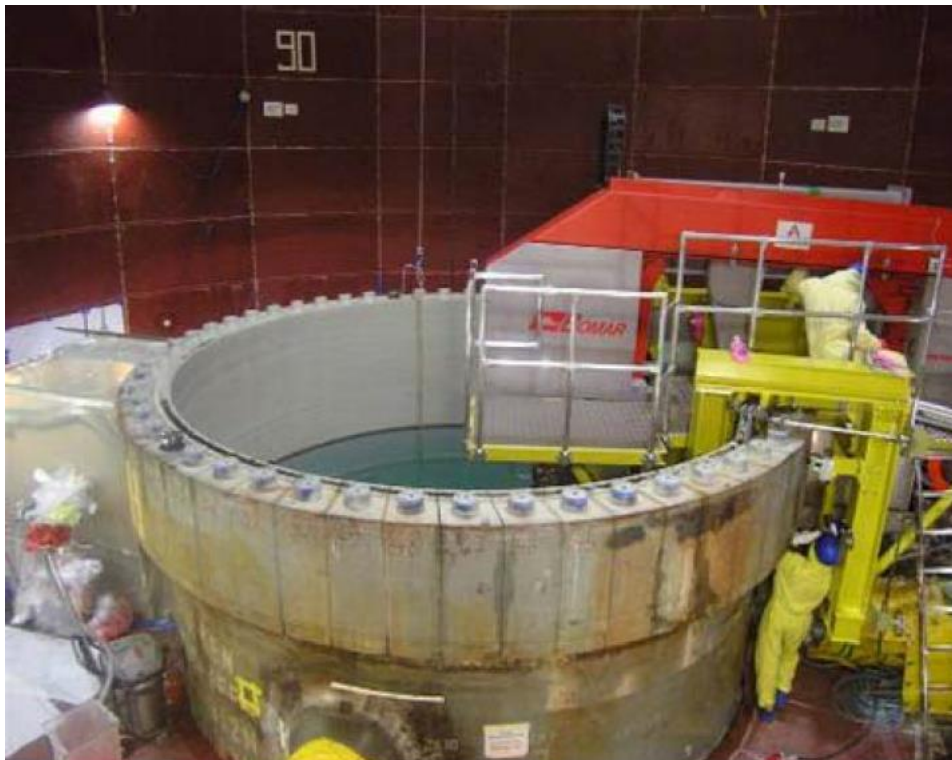
圖 22：帶鋸切割 RPV 頂部凸緣(Würgassen)
