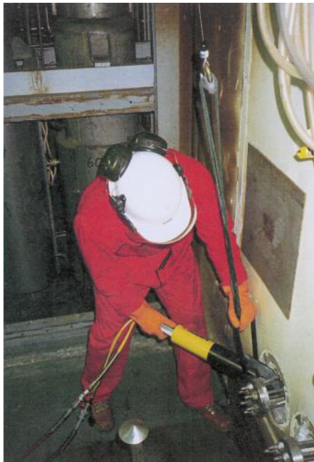
圖 17：攜帶型油壓剪現場作業(Kjeller reprocessing plant)
