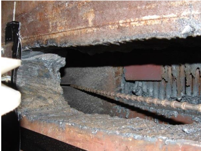
圖 34：鑽石索具切割蒸汽產生器(Rancho Seco)
