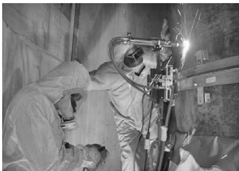
圖 2：半自動化的氧-燃料切割 RPV 外殼(KRB-A)
