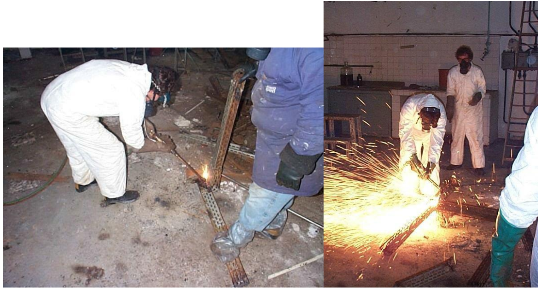
圖 6：氧-乙炔火炬現場切割碳鋼結構(IPEN/CNEN-SP)
