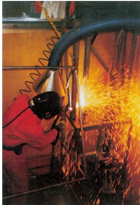
圖 10：電漿火炬切割(Kjeller reprocessing plant, Norway)
