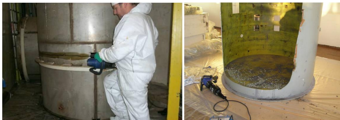
圖 19：壓穿式電剪拆除切割桶槽(IPEN/CNEN-SP)
