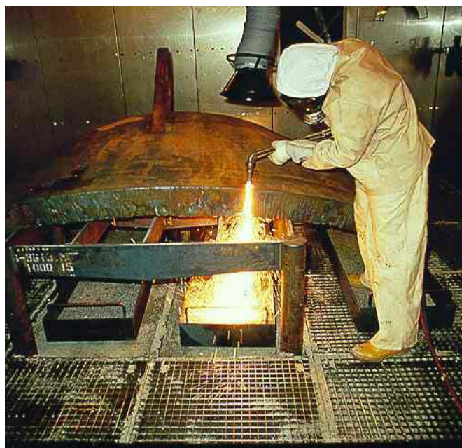
圖 1：氧-燃料切割 RPV 頂蓋(KRB-A)
