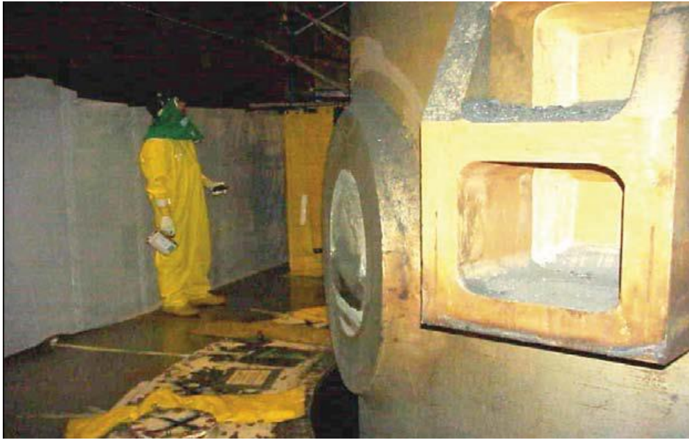
圖 31：鑽石索具切割反應器噴嘴(San Onofre unit 1)
