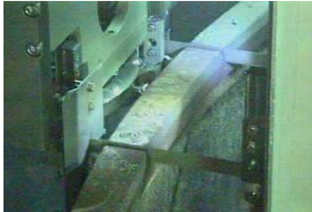
圖 20：帶鋸切割爐心側板(Würgassen)
