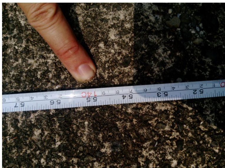
圖5-11 樓梯坡度之水平距離140公分
