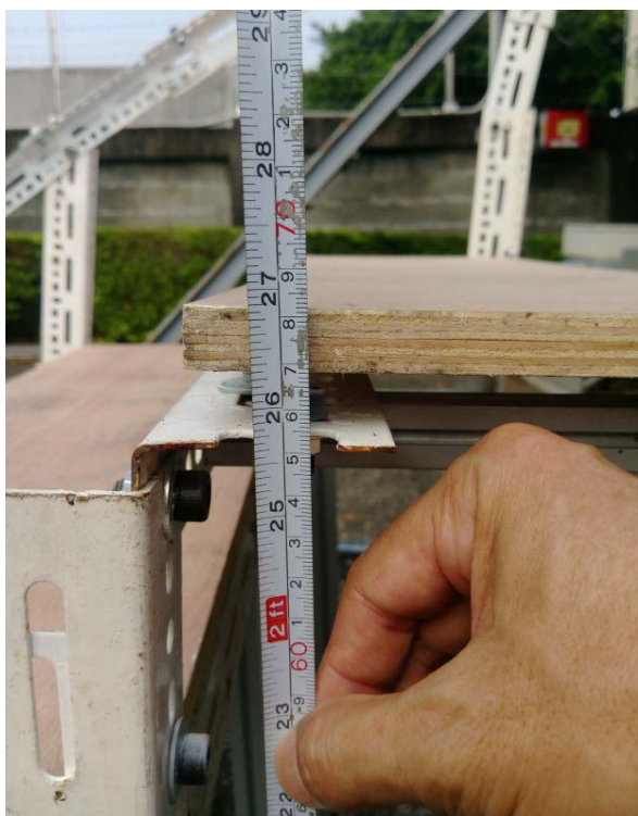
圖5-9 樓梯坡度之垂直高度68.1公分
