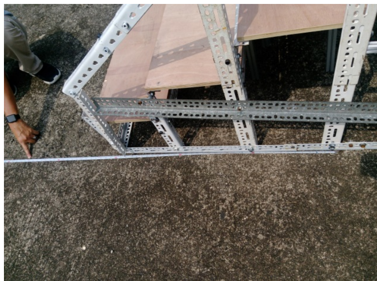
圖5-10 樓梯坡度之水平距離量測
