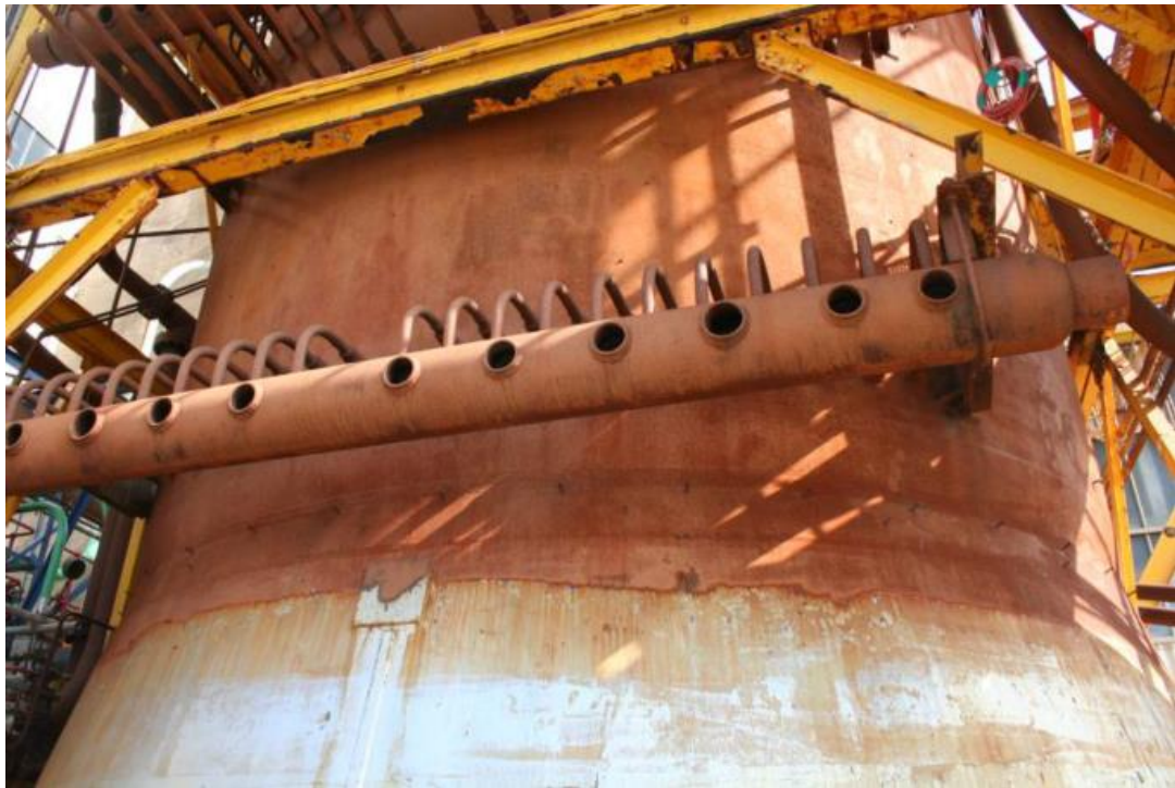
圖 4.14 熱交換器蒸氣系統頂座
