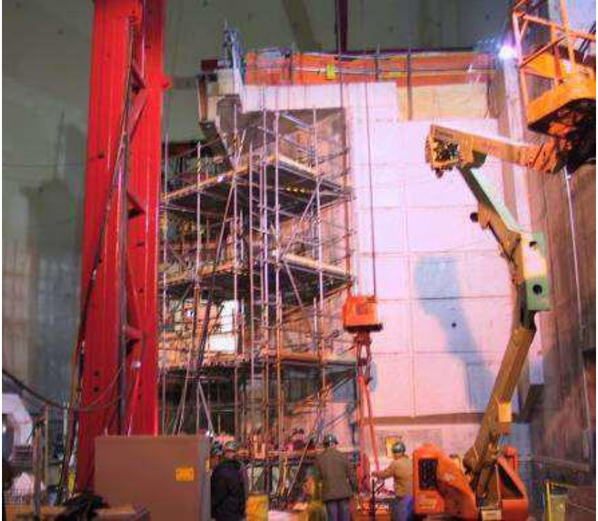
圖 3.2 美國 Big Rock Point 核電廠利用鑽石索鋸的照片
