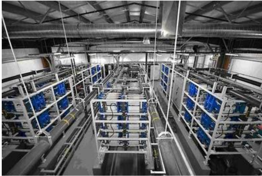
圖 1-1 中國大陸普能公司與美國加利福尼亞州的Gills Onions合作建造的全鈦液流電池系統(3.6 MWh)[8]
