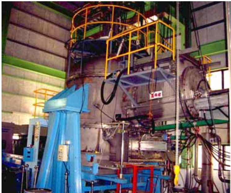
圖 3-1 核能研究所非放射性先導型電漿焚化熔融爐外觀照片
