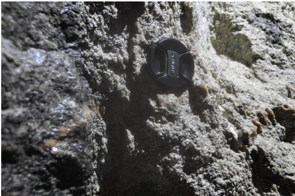
圖4.2-14 翟山坑道側壁處基性岩脈與花崗片麻岩交界處已呈現風化現象
