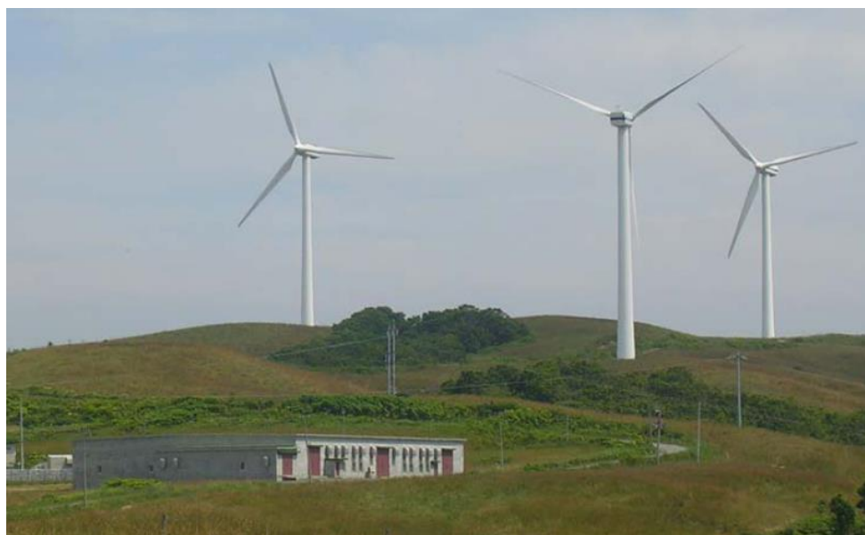
圖 4、在日本Sapporo 建立32MW風力發電廠。 電廠使用儲電功率4 MW、1.5 h尖峰功率為6 MW的VRB電池來平整 電廠輸出電壓。
