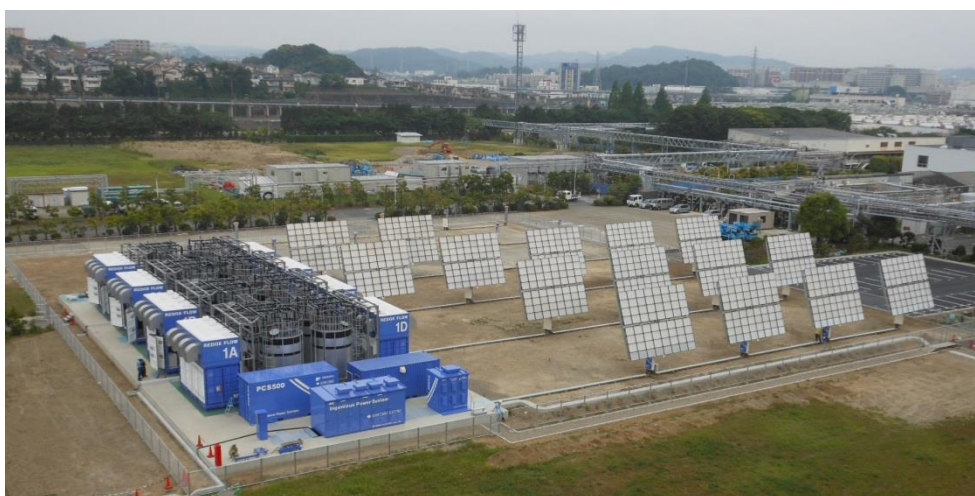
圖 5、住友電工在橫濱廠(Yokohama Works)建置1 MW/5 MWh的VRFB儲電系統 [7]。
