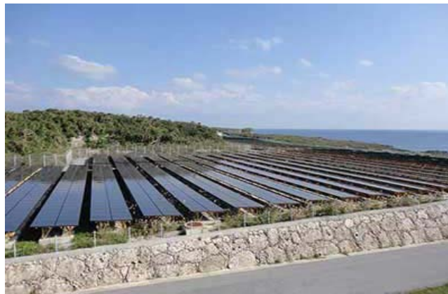
圖 19 傾角 5 度之太陽能電池板。
