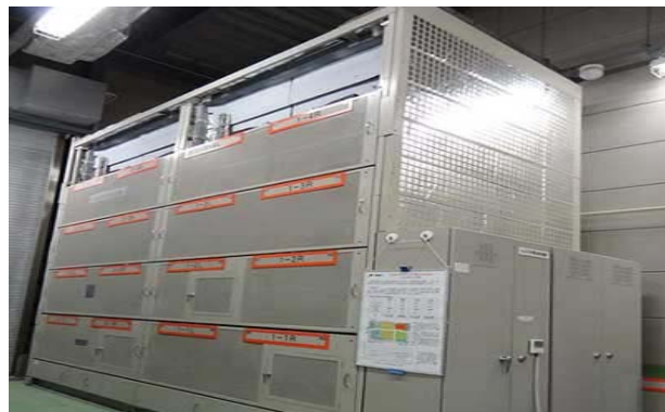
圖 21 設置總功率為 4MW 的日本礙子產的 NaS（硫化鈉）電池
