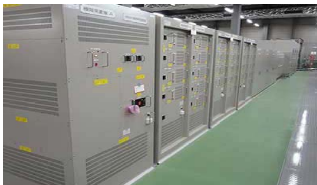
圖 22 模擬 100 個普通家庭及學校等 4 個用電大戶的配電系統
