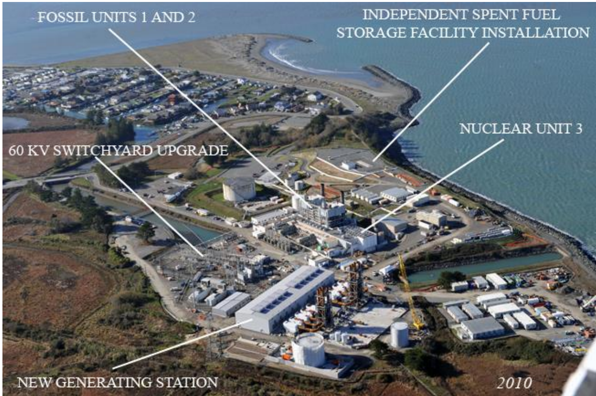
圖 4.1 美國 Humboldt Bay 發電廠。
