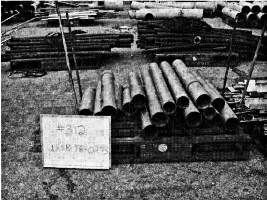
圖 3.4 成堆放置等待外釋調查之拆除物件。圖中為裁切為特定長度的大口徑管道，調整至指定大小置放於托盤或棧板整齊擺放。(Eric. W. Abelquist, Decommissioning Health Physics: A Handbook for MARSSIM Users, 2 nd edition)
