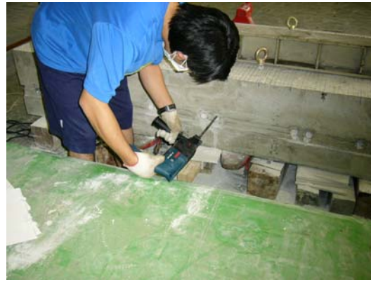
圖 32、用電鑽將較硬之膨脹水泥挖除
