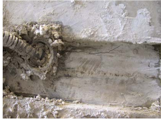
圖 30、開始微裂縫產生(約 0.35mm)
