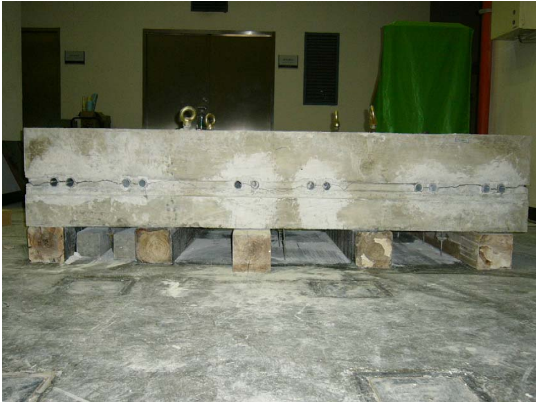
圖 47、預埋鋼筋及塑膠管之試體開裂之情況(正面)
