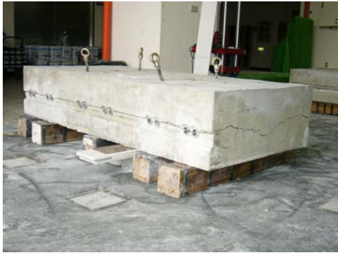
圖 52、預埋塑膠管試體之開裂情況
