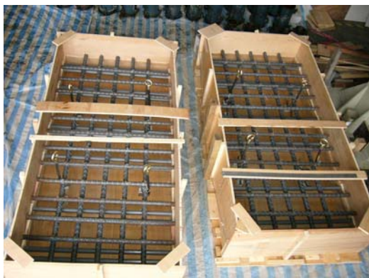
圖 14、二個預埋有塑膠管及鋼筋 之模板
