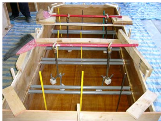
圖 17、預埋鐵條與熱縮套管
