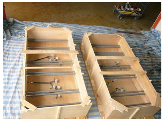
圖 15、二個僅預埋塑膠管之模板
