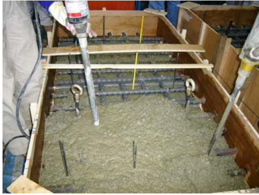
圖 18、澆置混凝土
