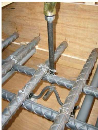
圖 16、鋼筋排列方式
