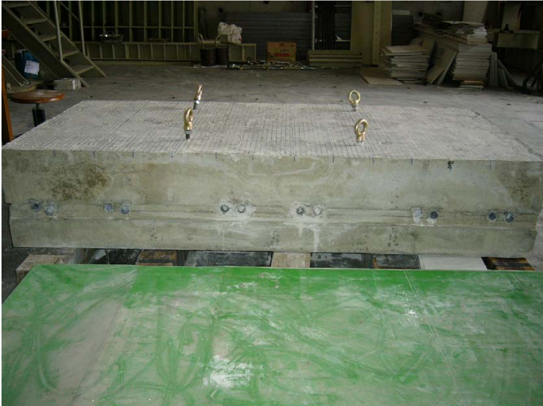
圖 50、預埋鋼筋及塑膠管試體開裂之情況(背面)
