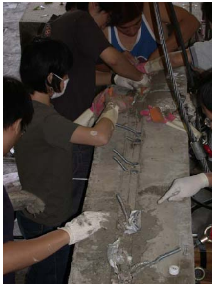
圖 28、將膨脹水泥灌入 PVC 管
