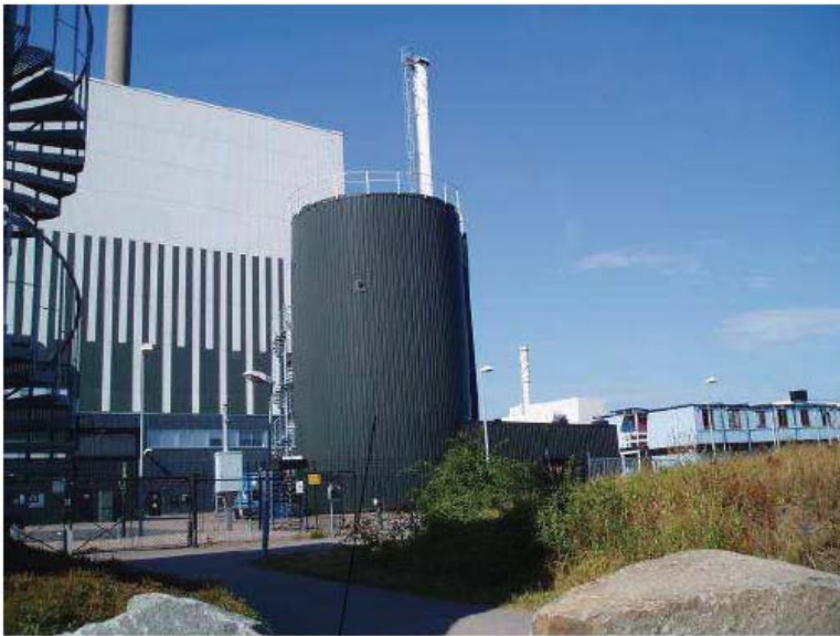
圖 3.2.77 Oskarsham 電廠(Sweden)的大氣排氣系統(ABB)
