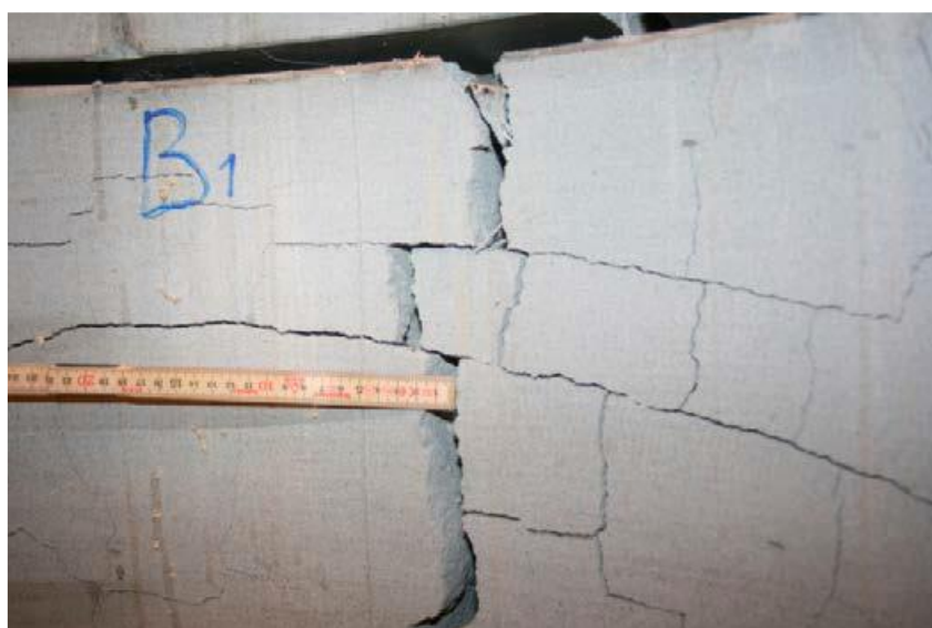
圖 2.23 緩衝材料內的裂紋
