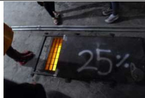
圖 8 參觀 Hong-ji-mun 隧道排煙坑道之排煙口
