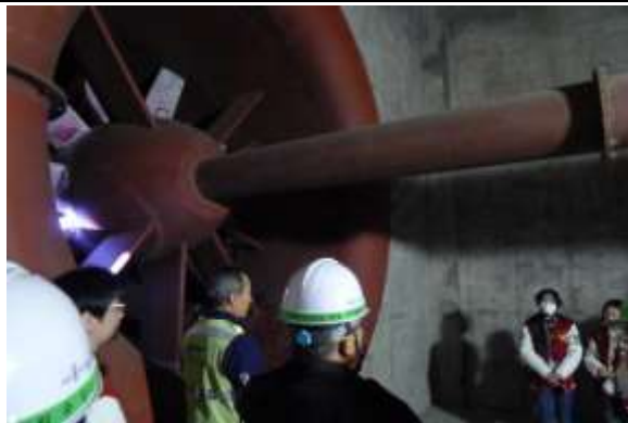
圖 6 參觀 Hong-ji-mun 隧道通風/排煙裝置
