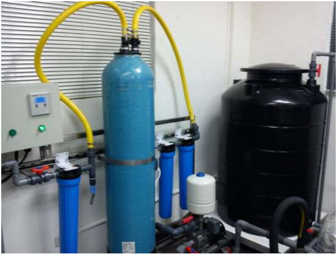
圖 3.4.2.2 實驗用 R.O.逆滲透純水過濾系統
