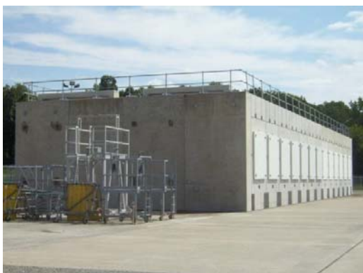
圖 7-44 NAPS NUHOMS 水平桶與剝落情形
