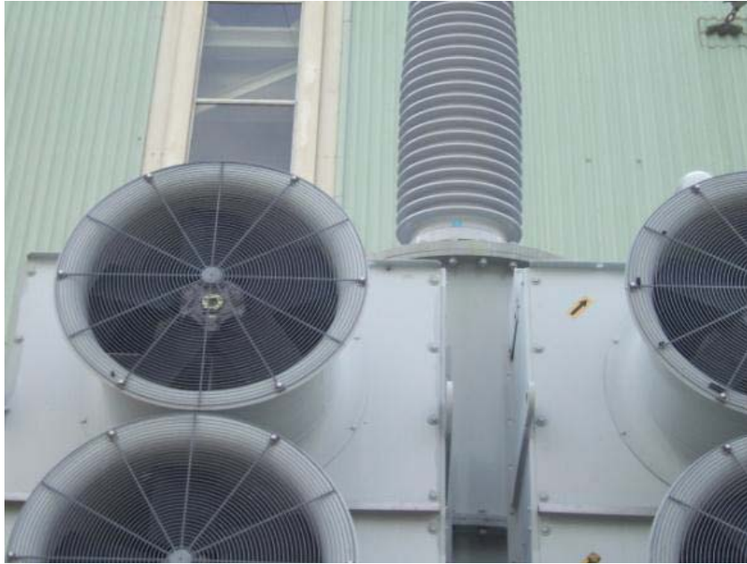
圖 7-42 NAPS 變壓器套管
