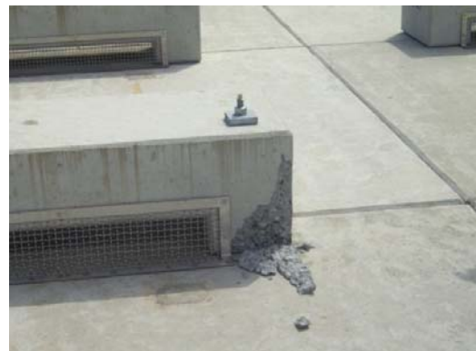
圖 7-44 NAPS NUHOMS 水平桶與剝落情形
