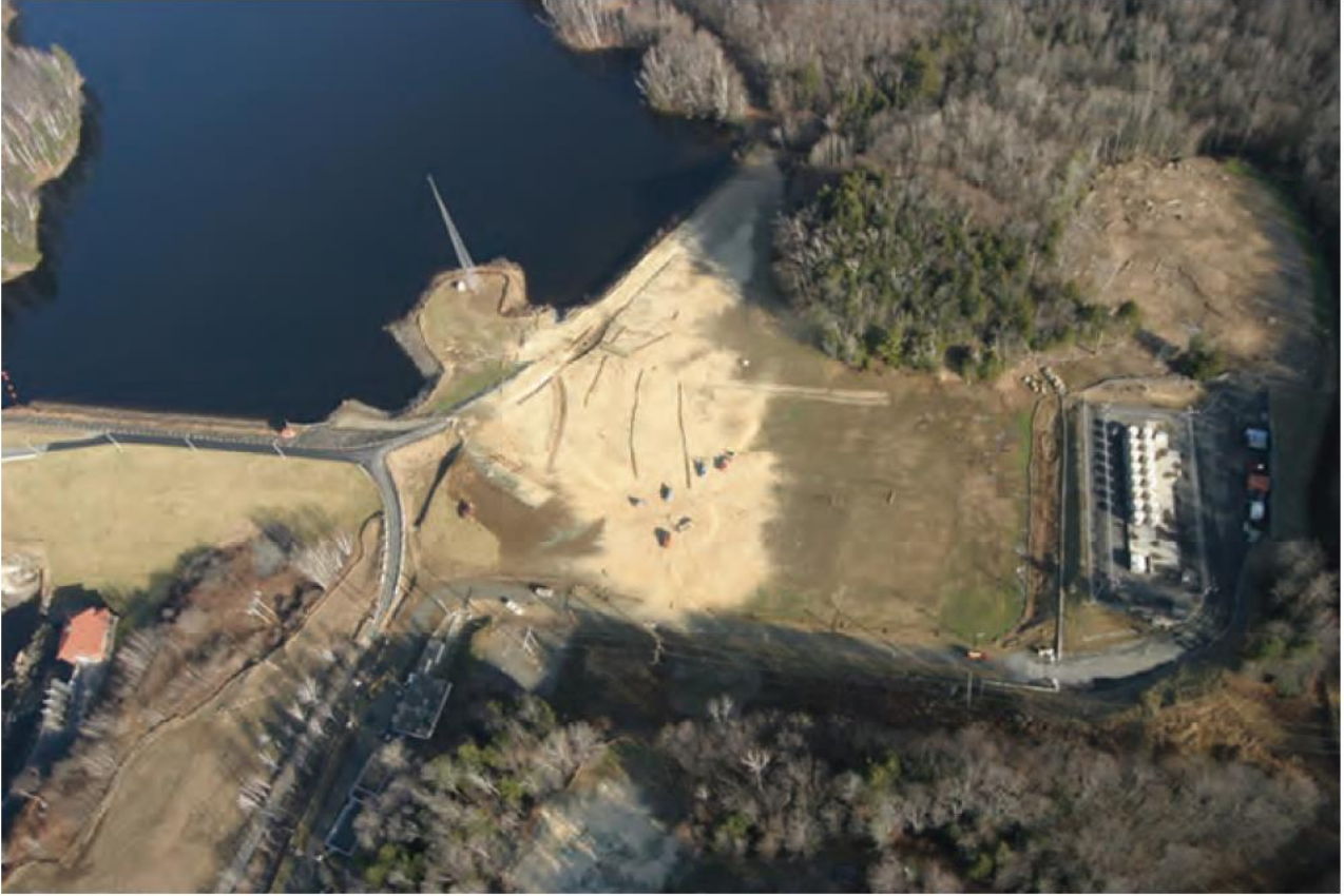
圖 4-3 Yankee Rowe 發電廠廠址開放後的狀況
